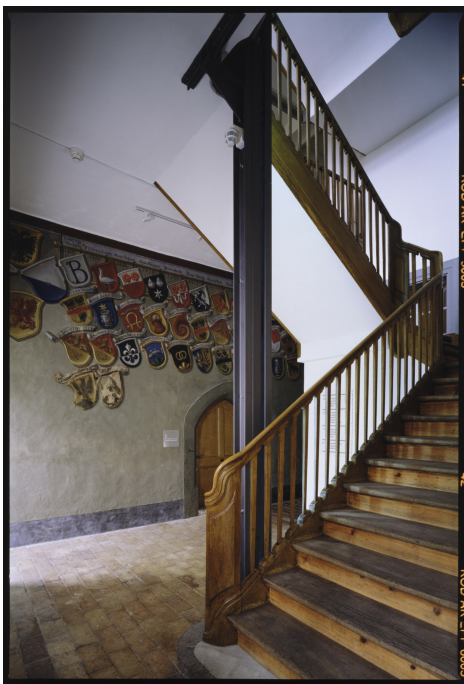
Schloss Greifensee, Schloss Greifensee (Vers.-Nr. 00082), Eingangshalle im EG mit gemalter «Wappentafel» (16. Jh.) und Treppenanlage mit statischer Verstärkung, 02.05.1995 (Bild Nr. L37434_01).
