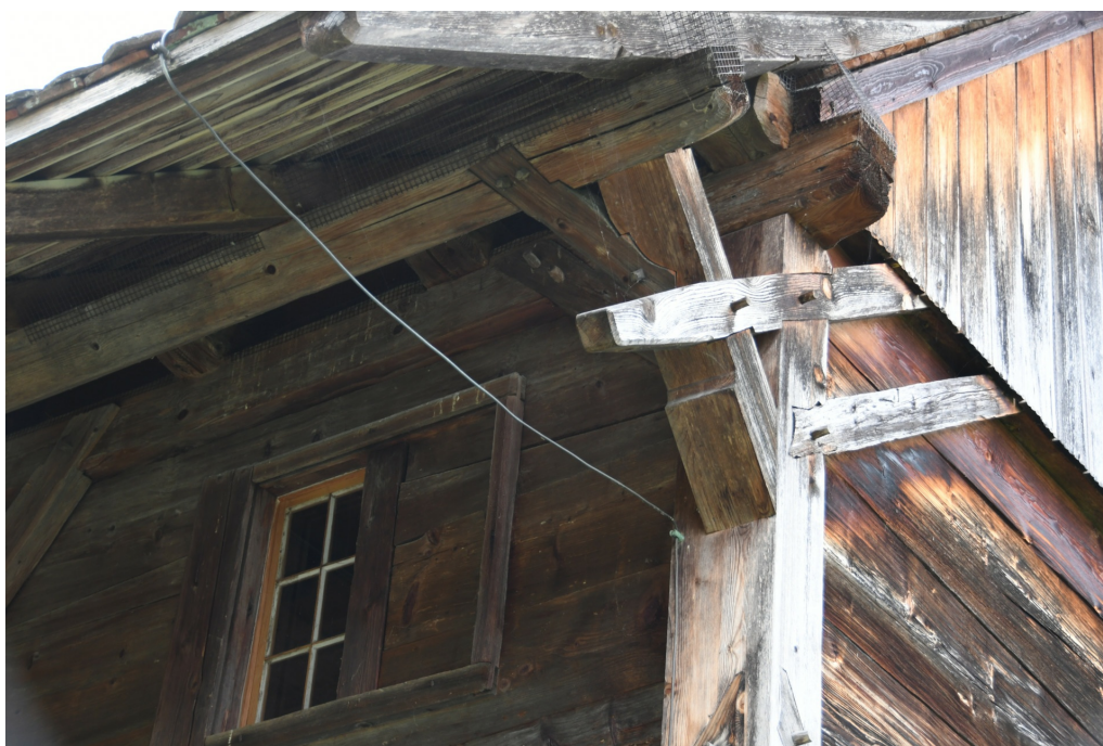
Speicher mit Keller, Speicher (Vers.-Nr. 0041), Vordachkonstruktion an der Südecke, Flugpfette mit angeblatteten Streben und Zügen, 22.08.2019 (Bild Nr. D100595_67).
