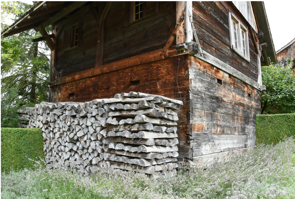
Speicher mit Keller, Speicher (Vers.-Nr. 00041), EG als Blockbau mit verzinkten Eckverbindungen, OG als Bohlenständerbau auf Schwellenkranz mit Schwellenschlössern und angeblatteten Bügen (Streben) in den Ecken, Ansicht von S, 22.08.2019 (Bild Nr. D100595_65).
