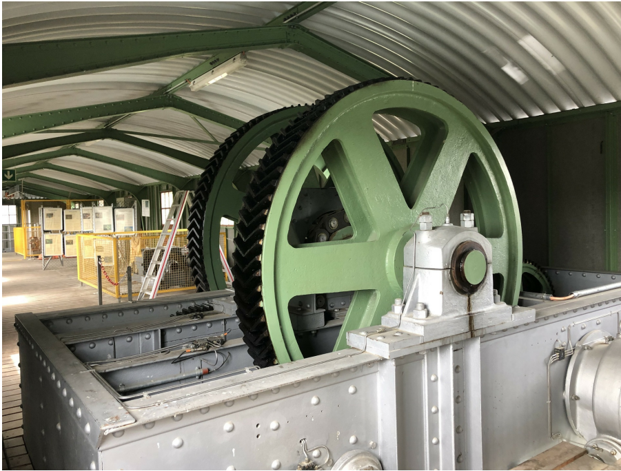
Kraftwerk Eglisau, Kraftwerk Eglisau, Windwerkbrücke mit Wehrantrieb, (Vers. Nr. 01658), Dienststeg mit Wehrantrieb, Blick nach NW, 18.05.2019 (Bild Nr. D100567_09).
