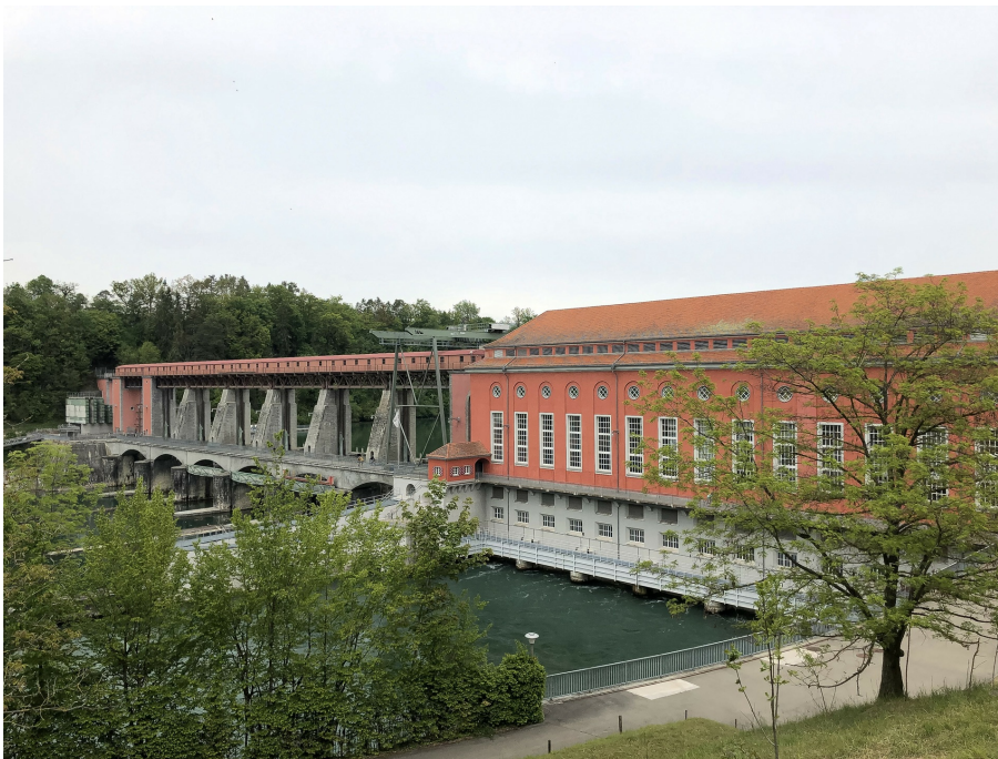
Kraftwerk Eglisau, Stauwehr (058STAUWEHR01656), Windwerkbrücke mit Wehrantrieb (Vers. Nr. 01658) und Maschinenhaus (Vers. Nr. 01656), Ansicht von S, 18.05.2019 (Bild Nr. D100567_02).
