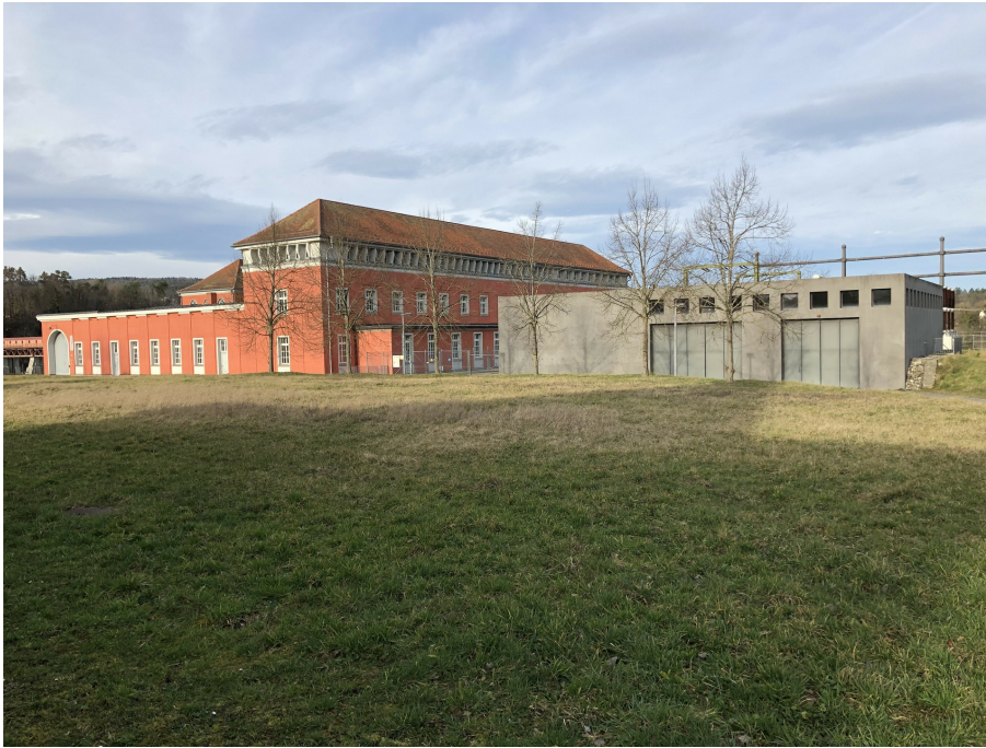
Kraftwerk Eglisau, Schalthaus (Vers. Nr. 01655) mit Unterwerk, Ansicht von W, 22.02.2020 (Bild Nr. D100567_20).
