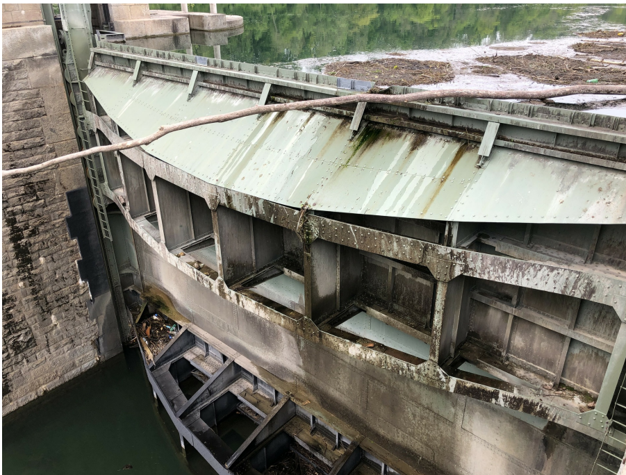
Kraftwerk Eglisau, Stauwehr (058STAUWEHR01656), zweiteilige Hub-Tafelschütze, Ansicht von S, 18.05.2019 (Bild Nr. D100567_07).
