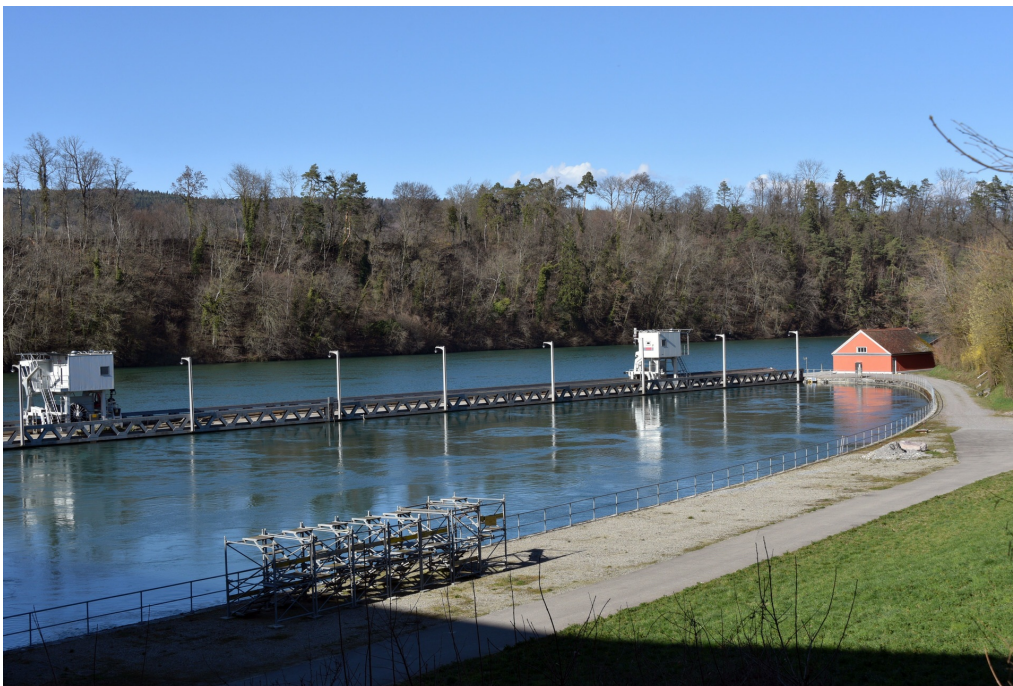
Kraftwerk Eglisau, Wasserkraftanlage (058WR-BUELACH00010), Oberwasserbecken mit Aussenrechen, Ansicht von S, 13.03.2020 (Bild Nr. D100567_22).
