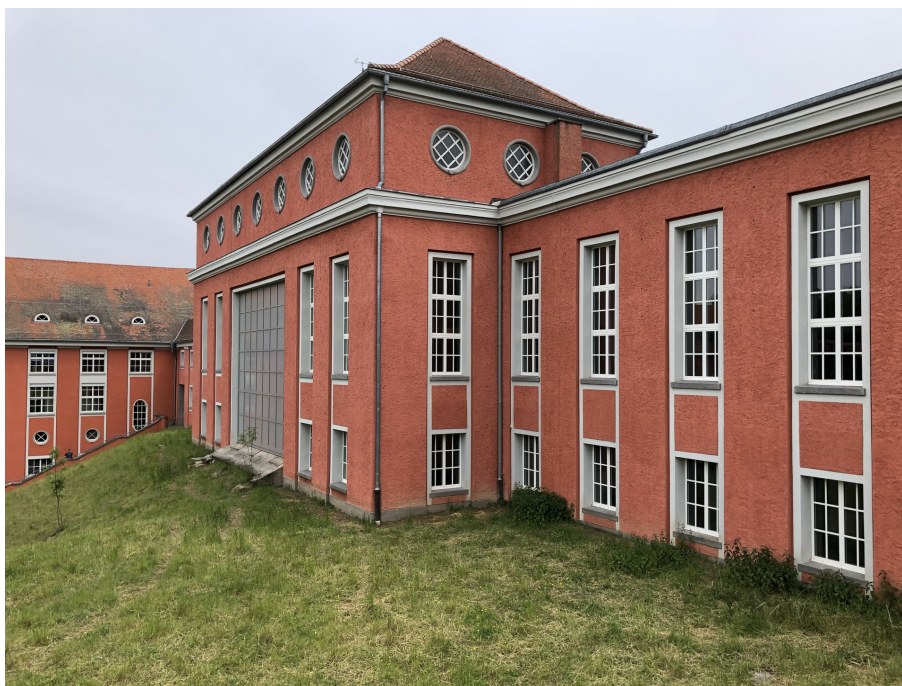
Kraftwerk Eglisau, Schalthaus (Vers. Nr. 01655) mit Bremsberg, Ansicht von W, 18.05.2019 (Bild Nr. D100567_17).
