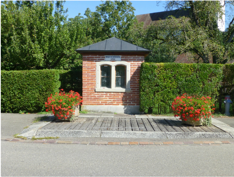
Brückenwaage, Ansicht von S, 27.08.2015 (Bild Nr. D100576_03).
