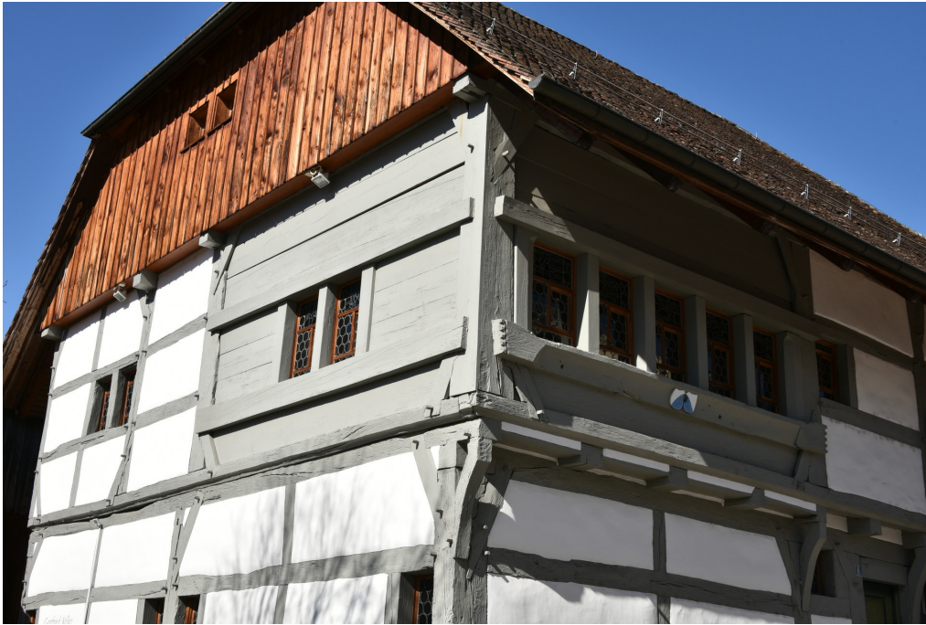
Sog. «Klingelegehaus», Bohlenbretter-Stube im OG, Ansicht von S, 13.03.2020 (Bild Nr. D100576_30).
