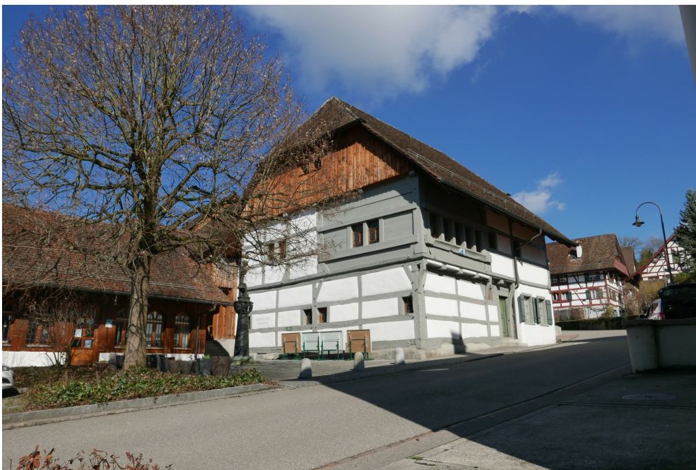
Sog. «Klingelegehaus», Ansicht von SO, 10.03.2017 (Bild Nr. D100576_22).
