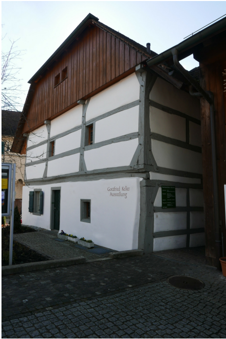
Sog. «Klingelegehaus», Ansicht von NW, 10.03.2017 (Bild Nr. D100576_28).
