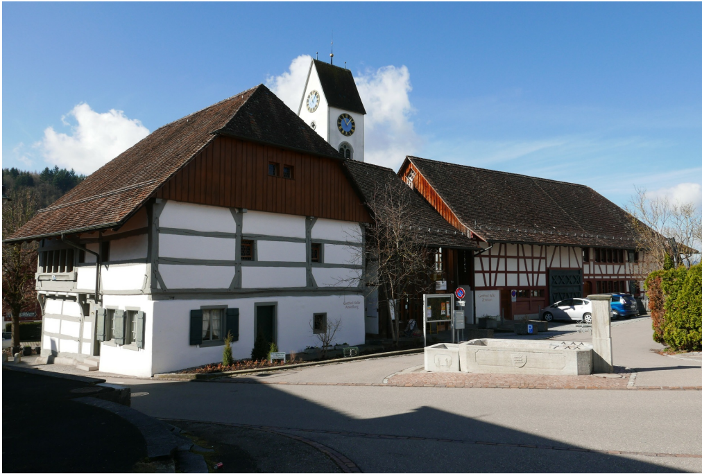
Sog. «Klingelegehaus», Ansicht von NO, 10.03.2017 (Bild Nr. D100576_21).
