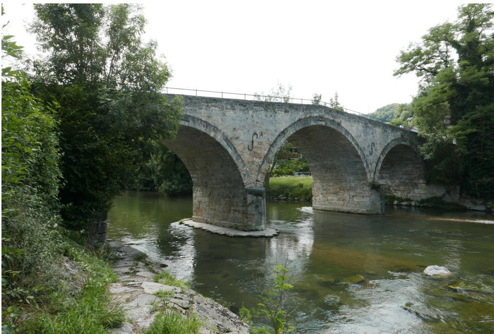
«Römerbrücke», Ansicht von N, 31.07.2017 (Bild Nr. D100557_71).
