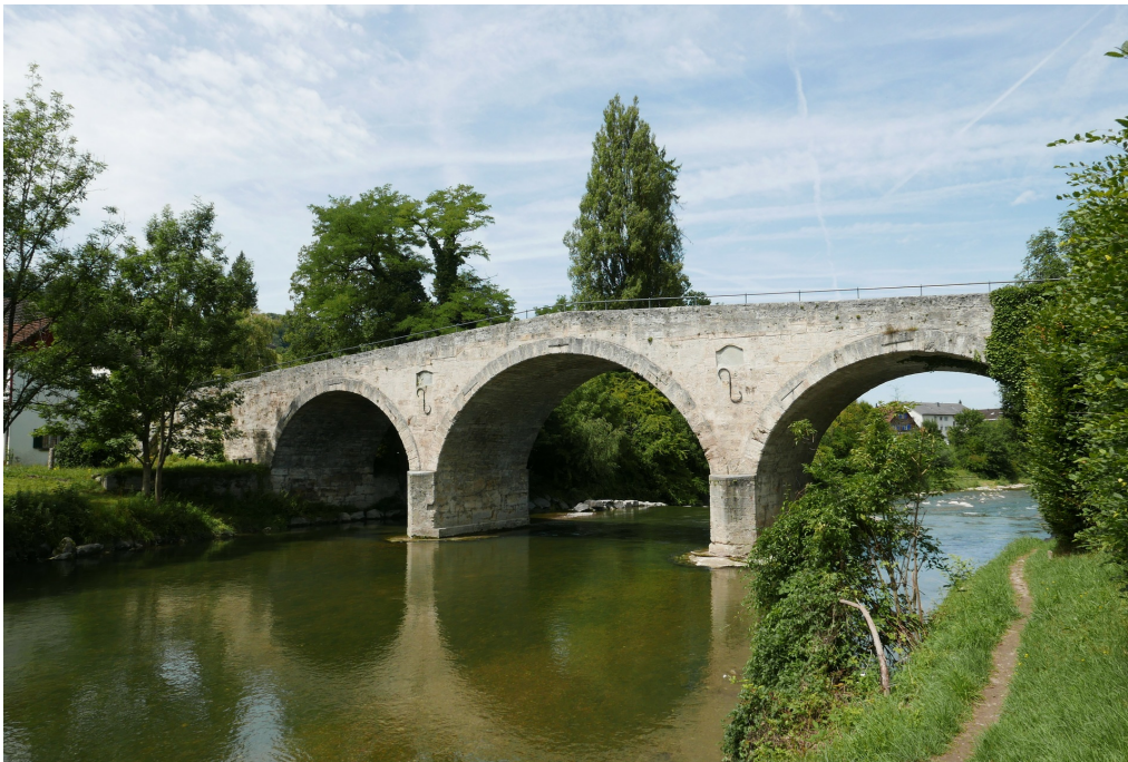
«Römerbrücke», Ansicht von SO, 31.07.2017 (Bild Nr. D100557_72).
