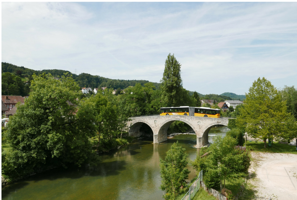
«Römerbrücke», Ansicht von SO, 31.07.2017 (Bild Nr. D100557_70).
