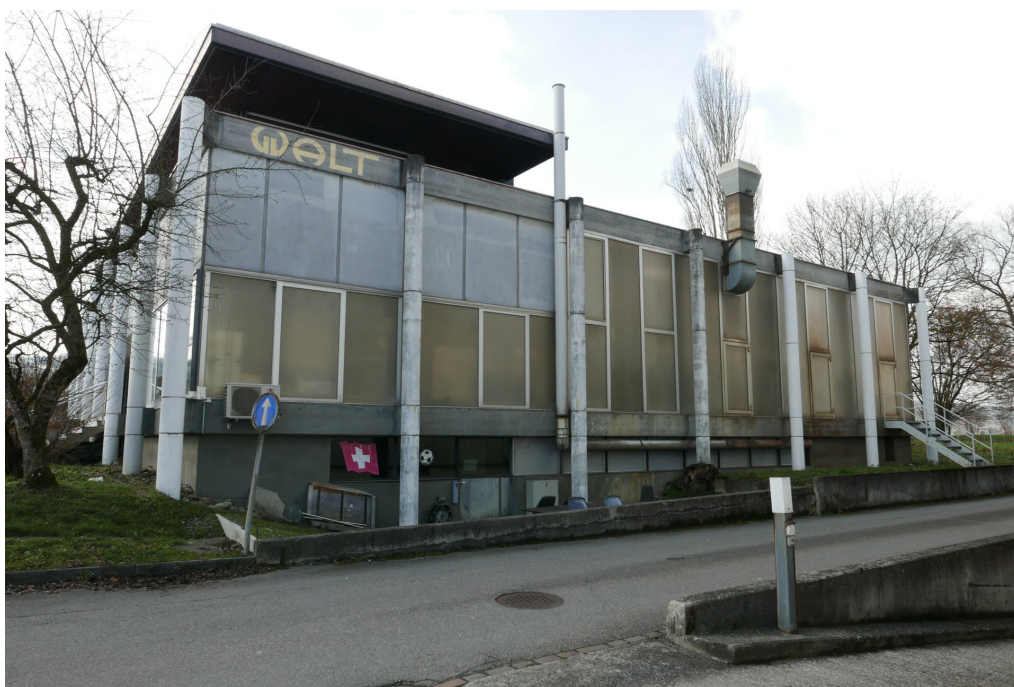
Galvanische Anstalt Walt, eine Stützenbreite entspricht drei Filtra-Sol-Gläsern, Ansicht von O, 26.02.2016 (Bild Nr. D100672_64).
