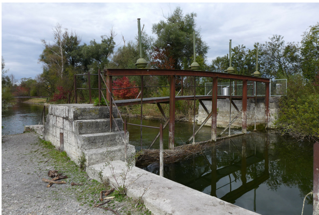
Greifenseewehr, Fallenwehr mit Holzbohlenschützen und Bedienungssteg, links abgetreppte Schleusenmauer mit ehem. Schiffsschleuse, Ansicht von SW, 19.10.2021 (Bild Nr. D101372_15).
