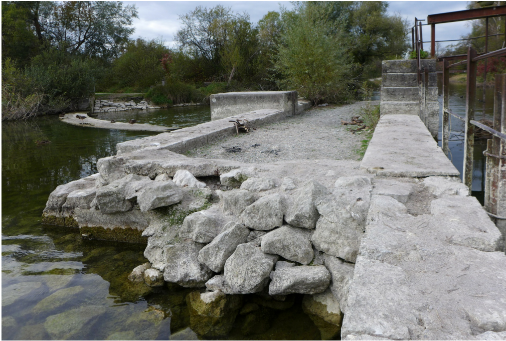
Greifenseewehr, mit Geröll und Kies gefüllte, ehem. Schiffsschleuse, Ansicht von SO, 19.10.2021 (Bild Nr. D101372_18).
