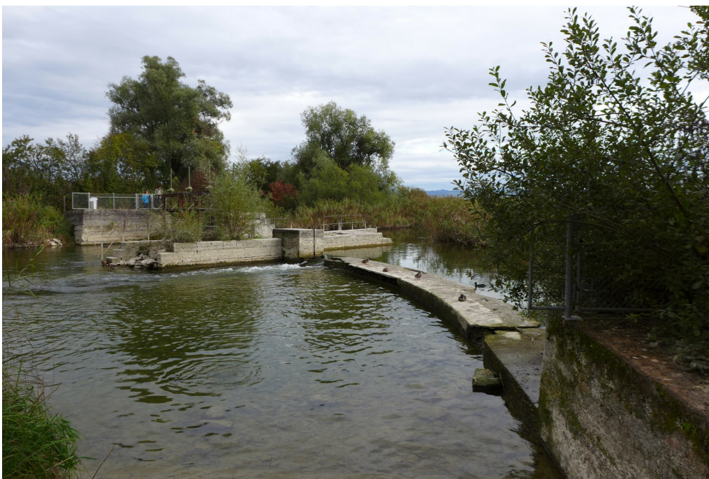
Greifenseewehr, vorne Überfallmauer, hinten ehem. Schiffsschleuse und Fallenwehr, Ansicht von O, 19.10.2021 (Bild Nr. D101372_30).
