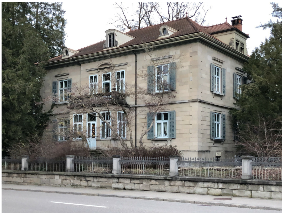
Villa Ganz mit Nebengebäuden, Villa Ganz (Vers. Nr. 00326), Ansicht von SW, 03.01.2020 (Bild Nr. D101098_01).
