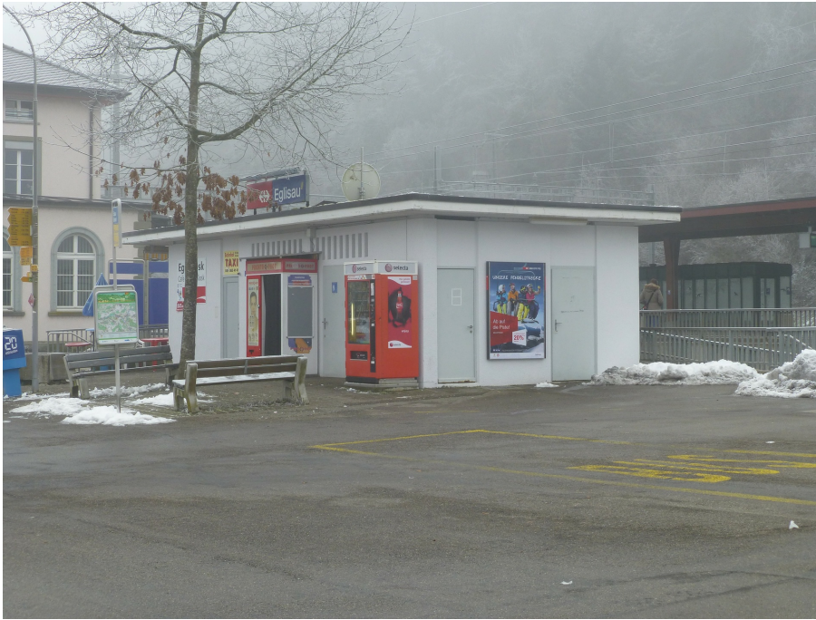
Bahnhof Eglisau, Kiosk- und WC-Gebäude (Vers. Nr. 00312), Ansicht von NW, 04.02.2019 (Bild Nr. D100560_69).
