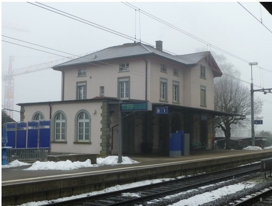
Bahnhof Eglisau, Aufnahmegebäude mit Perrondach (Vers. Nr. 00310), Ansicht von W, 04.02.2019 (Bild Nr. D100560_67).
