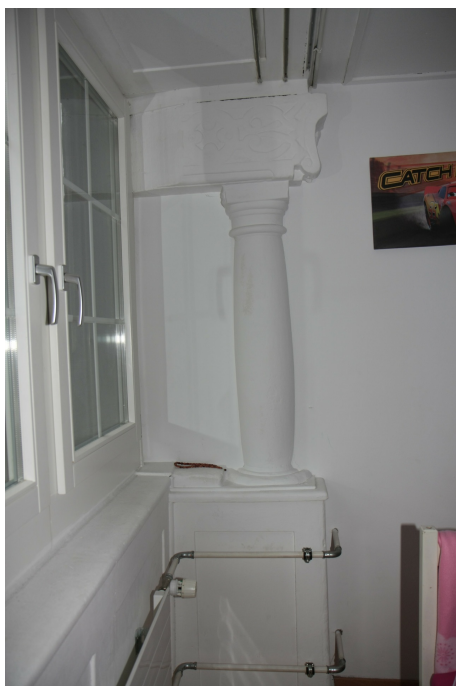
«Blaues Haus», Fenstersäule im EG, 15.11.2011 (Bild Nr. D101325_72).
