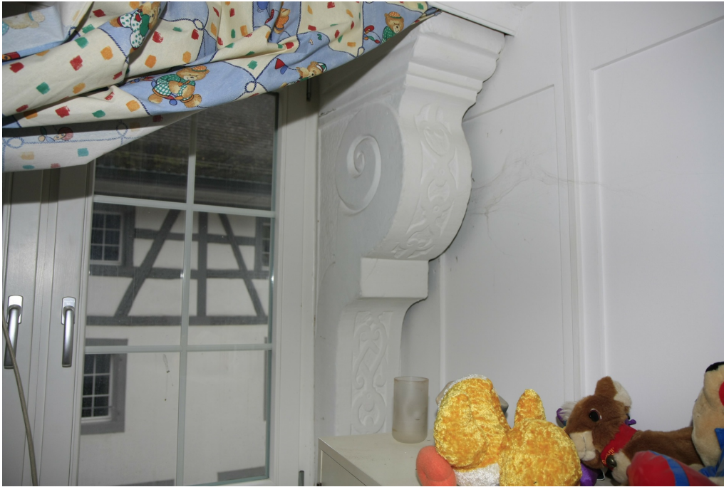
«Blaues Haus», Fensterpfeiler im 1. OG, 15.11.2011 (Bild Nr. D101325_75).
