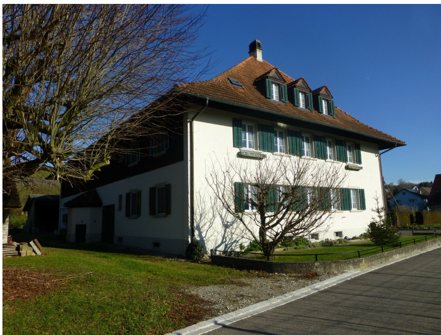
Aussiedlerhof Laufer, Vielzweckbauernhaus (Vers. Nr. 00520), Ansicht von SW, 14.01.2015 (Bild Nr. D100581_73).
