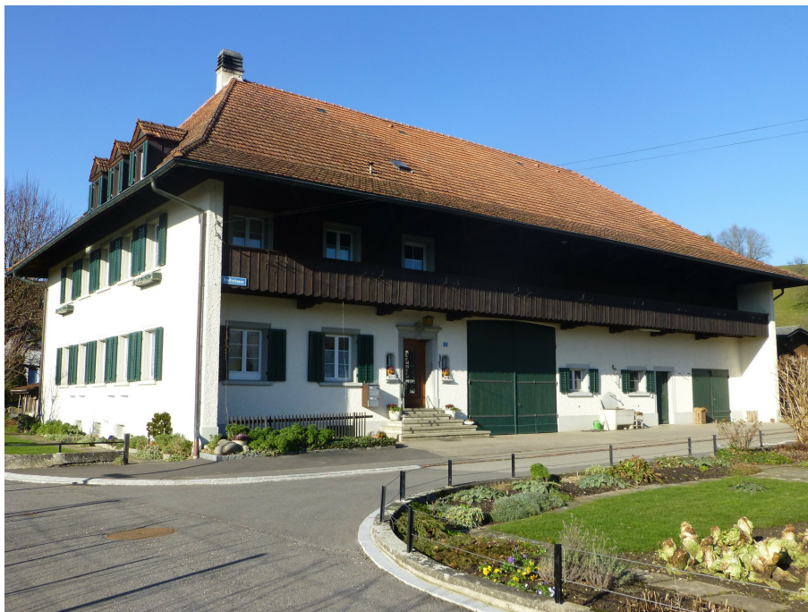
Aussiedlerhof Laufer, Vielzweckbauernhaus (Vers. Nr. 00520), Ansicht von SO, 14.01.2015 (Bild Nr. D100581_72).
