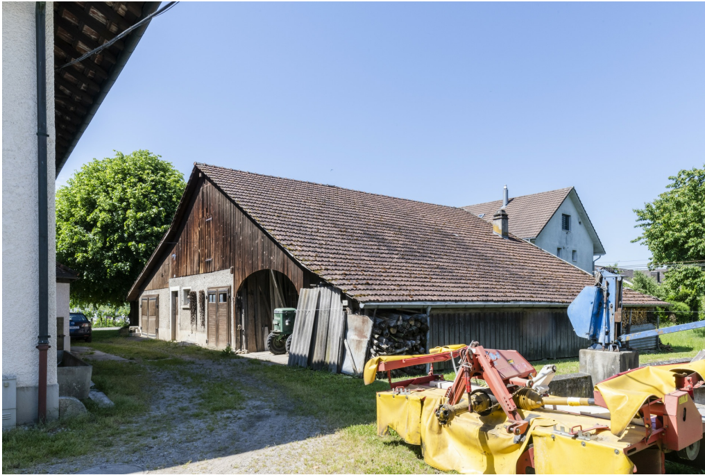
Aussiedlerhof Lauffer, Nebengebäude (Vers. Nr. 00522), Ansicht von NO, 28.05.2020 (Bild Nr. D101366_80).
