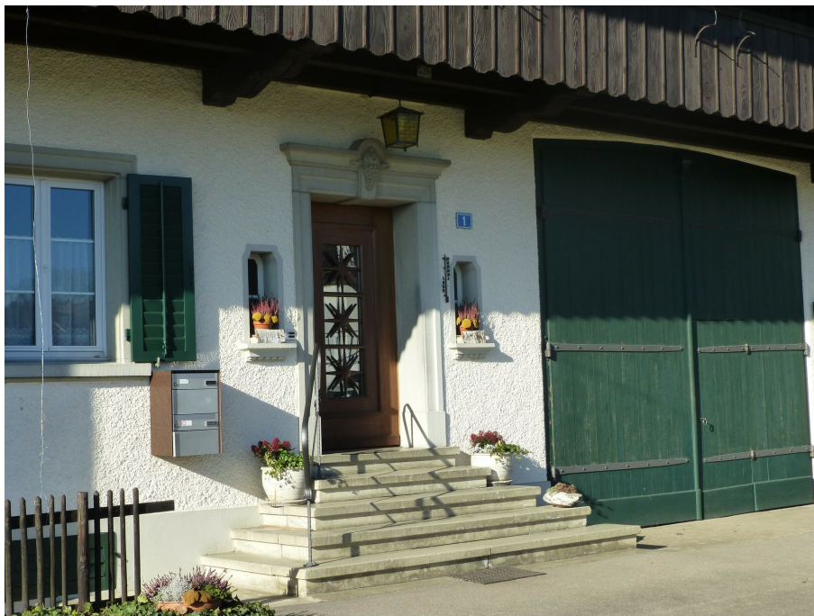
Aussiedlerhof Laufer, Vielzweckbauernhaus (Vers. Nr. 00520), Hauseingang und Scheunentor an der Ostfassade, 14.01.2015 (Bild Nr. D100581_74).
