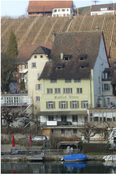
Gasthaus «Zur Krone», Ansicht von S, 04.02.2019 (Bild Nr. D101357_78).
