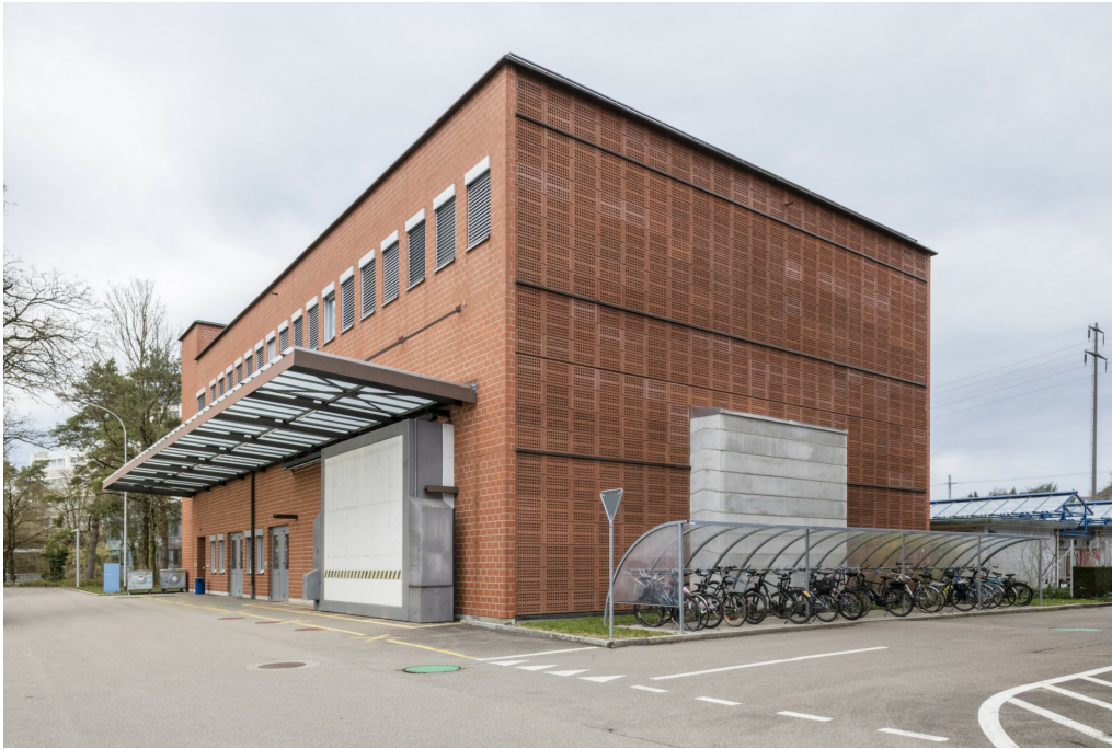
Eidgenössische Materialprüfungs- und Forschungsanstalt EMPA Dübendorf, Röntgenhaus (Vers.-Nr. 01057), an der Schmalseite Verdickung zum Schutz vor Strahlen, Ansicht von SO, 16.01.2023 (Bild Nr. D100674_85).
