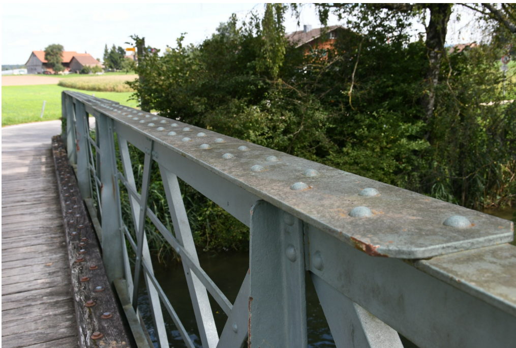
Glattsteg, genietete Stahlfachwerkkonstruktion, 04.09.2017 (Bild Nr. D100684_35).
