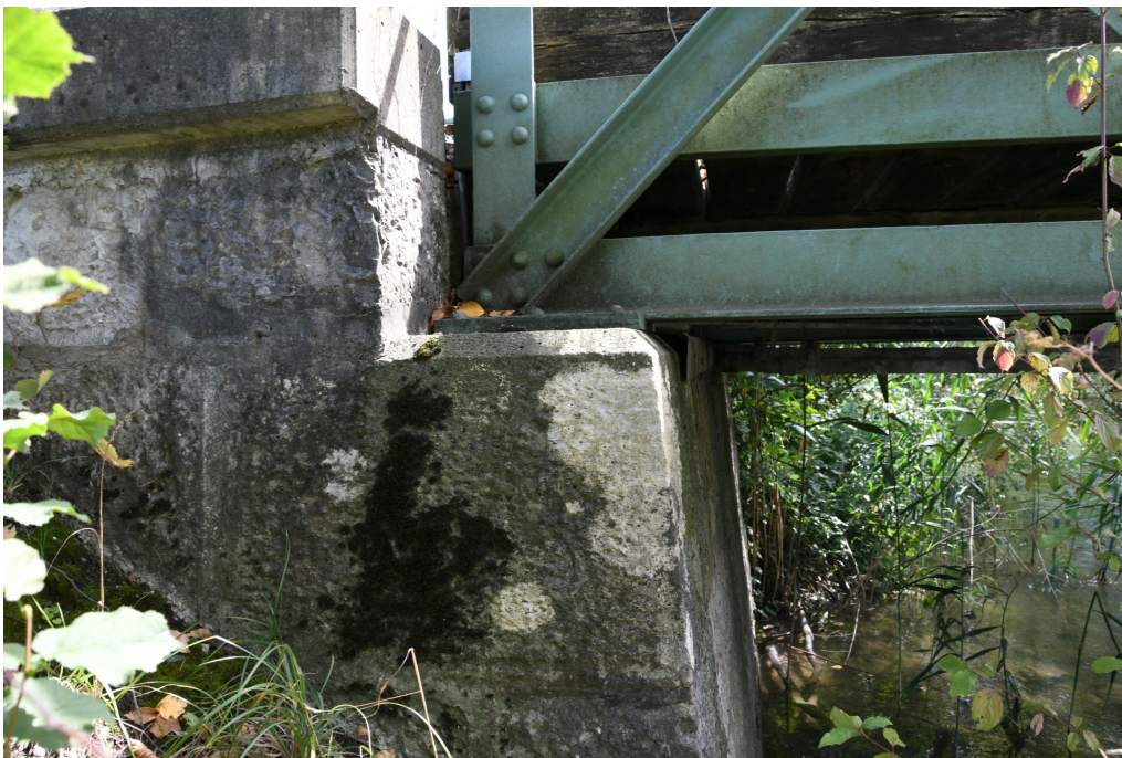
Glattsteg, Brückenwiderlager aus Granitquadern, 04.09.2017 (Bild Nr. D100684_37).
