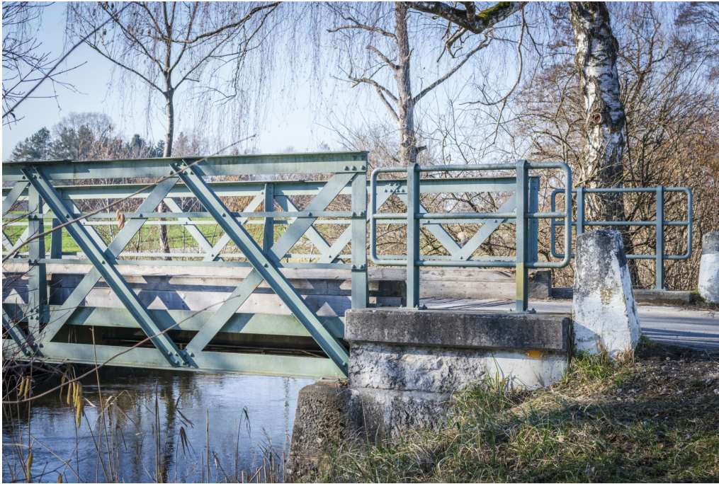
Glattsteg, Stahlfachwerkträger mit gekreuzten Streben und Brückenwiderlager aus Granitquadern, Ansicht von SO, 07.02.2023 (Bild Nr. D100684_20).
