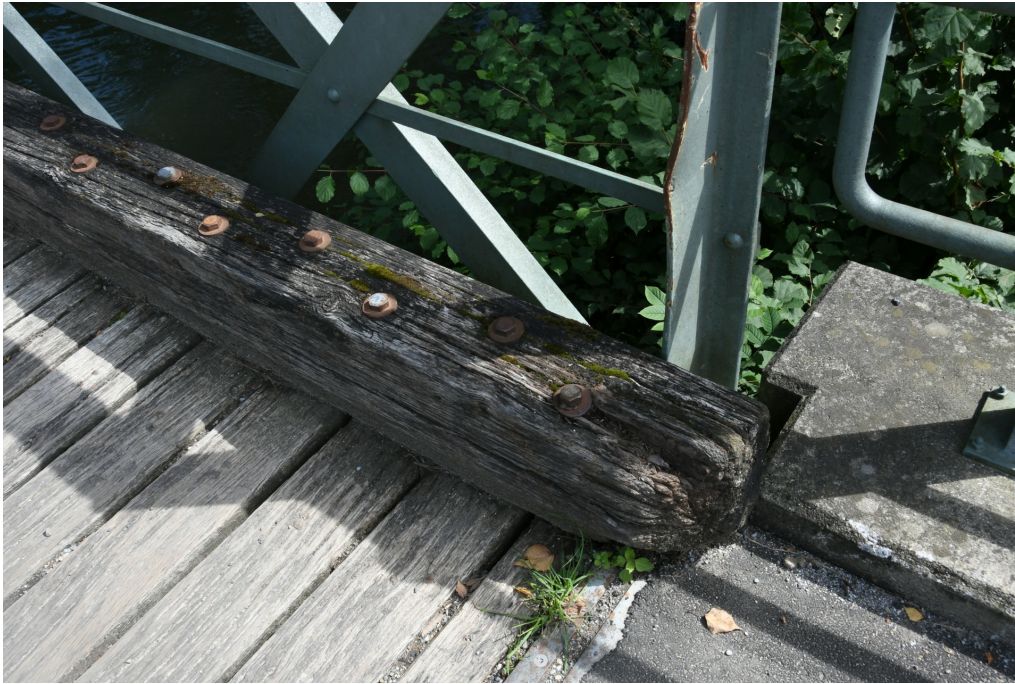
Glattsteg, hölzerne Fahrbahn mit aufliegendem Balken zur Stabilisierung, 04.09.2017 (Bild Nr. D100684_36).
