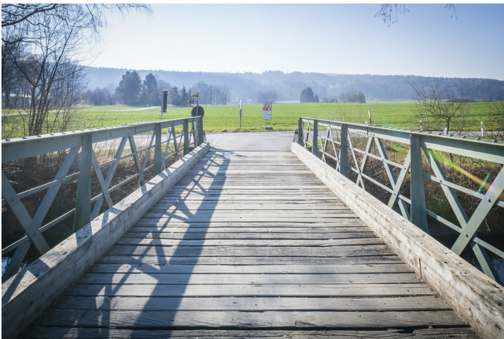
Glattsteg, hölzerne Fahrbahn zwischen Stahlfachwerkträgern, Blick nach SW, 07.02.2023 (Bild Nr. D100684_13).
