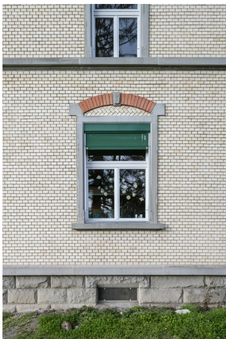
Schulhaus Gfenn, die Fenster im EG sind «geohrt», mit rotem Sichtbackstein und einem bossierten Schlussstein verziert, 10.11.2022 (Bild Nr. D100675_99).
