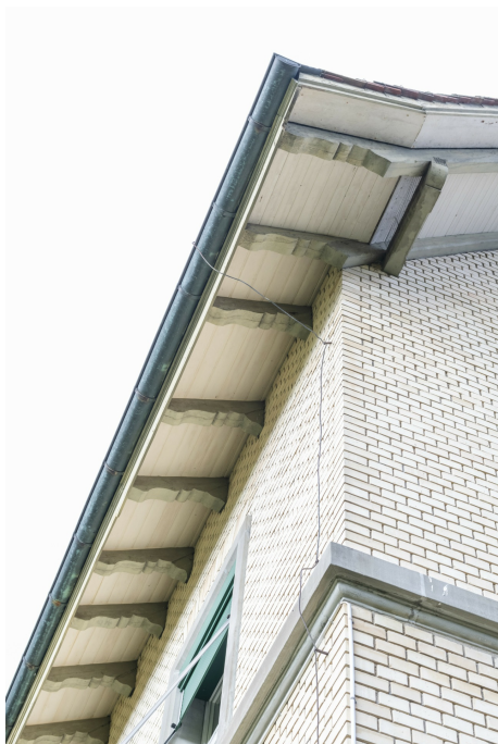
Schulhaus Gfenn, Dachuntersicht mit geschnitzten Aufschieblingen, 10.11.2022 (Bild Nr. D100676_74).
