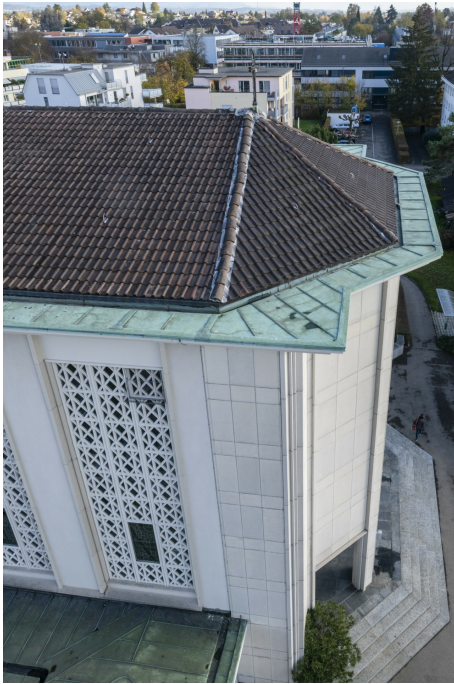
Kath. Kirche Maria Frieden, kath. Kirche (Vers.-Nr. 01669), Flugdach mit Kupferabdeckung am Dachrand sowie Betonmasswerkfenster, Ansicht vom Glockenturm im NW, 10.11.2022 (Bild Nr. D100684_54).
