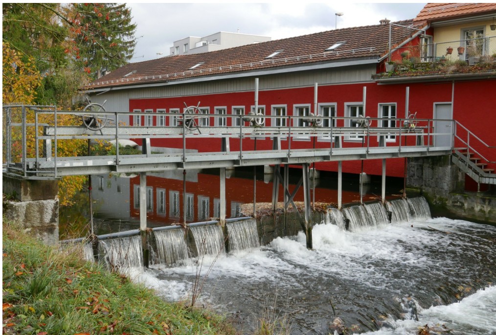
Ehem. Mühle Birchlen, Wasserkraftanlage, Stauwehr mit hochgezogenen Holzbrettern (191WR-g0004), Ansicht von NW, 05.11.2021 (Bild Nr. D100594_79).
