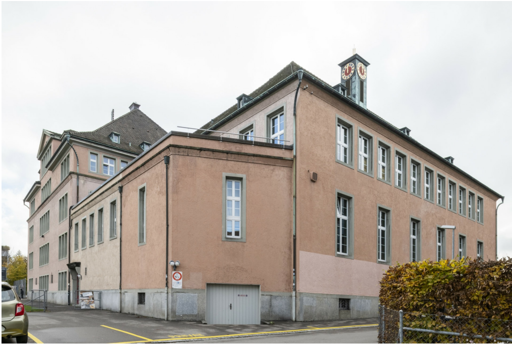
Schulanlage Dorf, Neues Schulhaus (Vers.-Nr. 01068), von links Klassentrakt, flachgedeckter Vorbau bei Verbindungsbau und Turnhallentrakt, Ansicht von NW, 10.11.2022 (Bild Nr. D101363_11).
