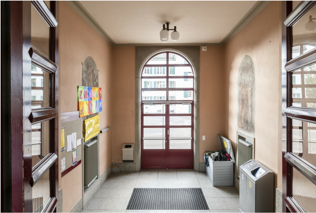
Schulanlage Dorf, Neues Schulhaus (Vers.-Nr. 01068), Vorhalle mit Wandbildern von Jakob Gubler, Blick nach SW, 10.11.2022 (Bild Nr. D101363_14).
