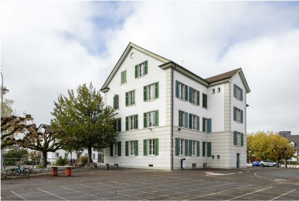
Schulanlage Dorf, Altes Schulhaus (Vers.-Nr. 00507), Ansicht von O, 10.11.2022 (Bild Nr. D101363_05).
