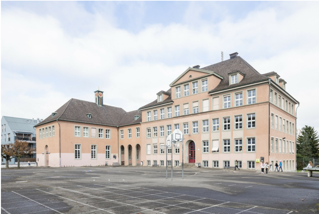
Schulanlage Dorf, Neues Schulhaus (Vers.-Nr. 01068), von links Turnhallentrakt, Verbindungsbau, Klassentrakt, Ansicht von S, 10.11.2022 (Bild Nr. D101363_07).
