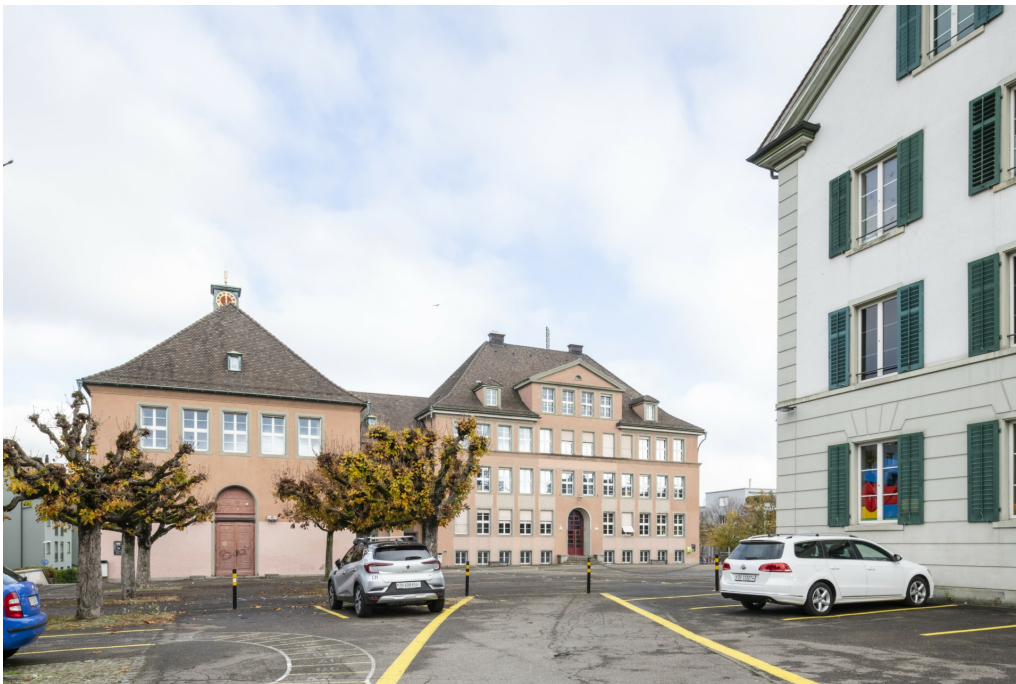
Schulanlage Dorf, Neues Schulhaus (Vers.-Nr. 01068) und Schulhausplatz mit historischer Baumreihe (191UMGEBU01068), Ansicht von SW, 10.11.2022 (Bild Nr. D100685_77).
