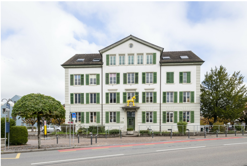
Schulanlage Dorf, Altes Schulhaus (Vers.-Nr. 00507), Ansicht von SW, 10.11.2022 (Bild Nr. D101363_03).
