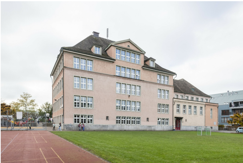
Schulanlage Dorf, Neues Schulhaus (Vers.-Nr. 01068), rechts flachgedeckter Vorbau beim Verbindungsbau, dahinter Turnhallentrakt, Ansicht von NO, 10.11.2022 (Bild Nr. D101363_12).
