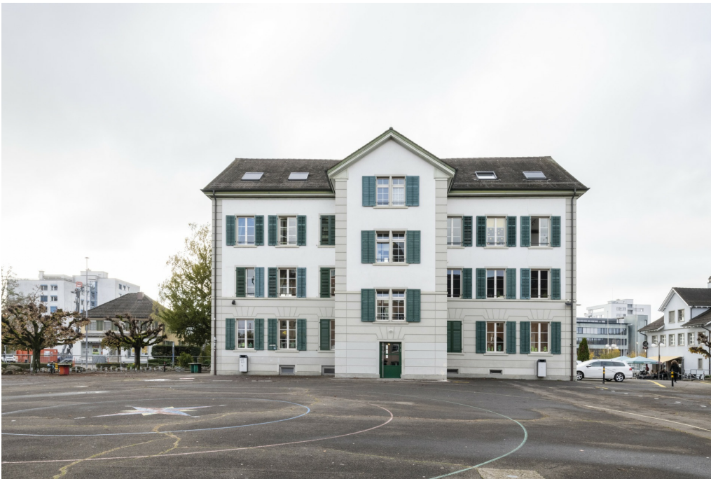
Schulanlage Dorf, Altes Schulhaus (Vers.-Nr. 00507), Ansicht von NO, 10.11.2022 (Bild Nr. D101363_06).
