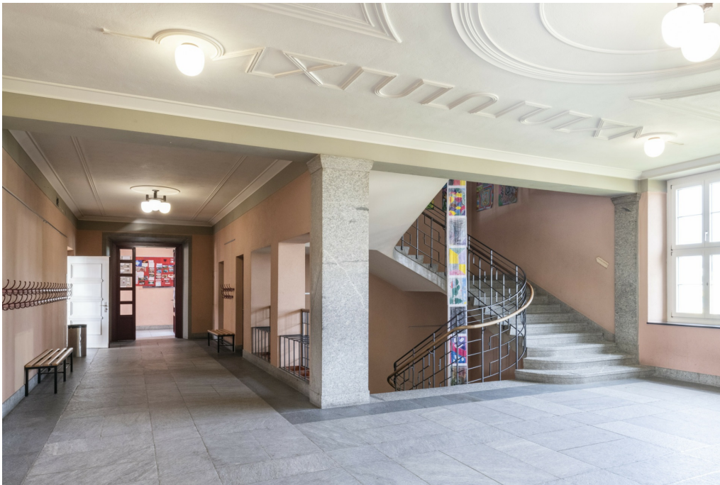
Schulanlage Dorf, Neues Schulhaus (Vers.-Nr. 01068), Treppenhalle im 1. OG mit Steinplattenboden und Ziermetallgeländer mit Handlauf aus Holz, Blick nach N, 10.11.2022 (Bild Nr. D101363_16).
