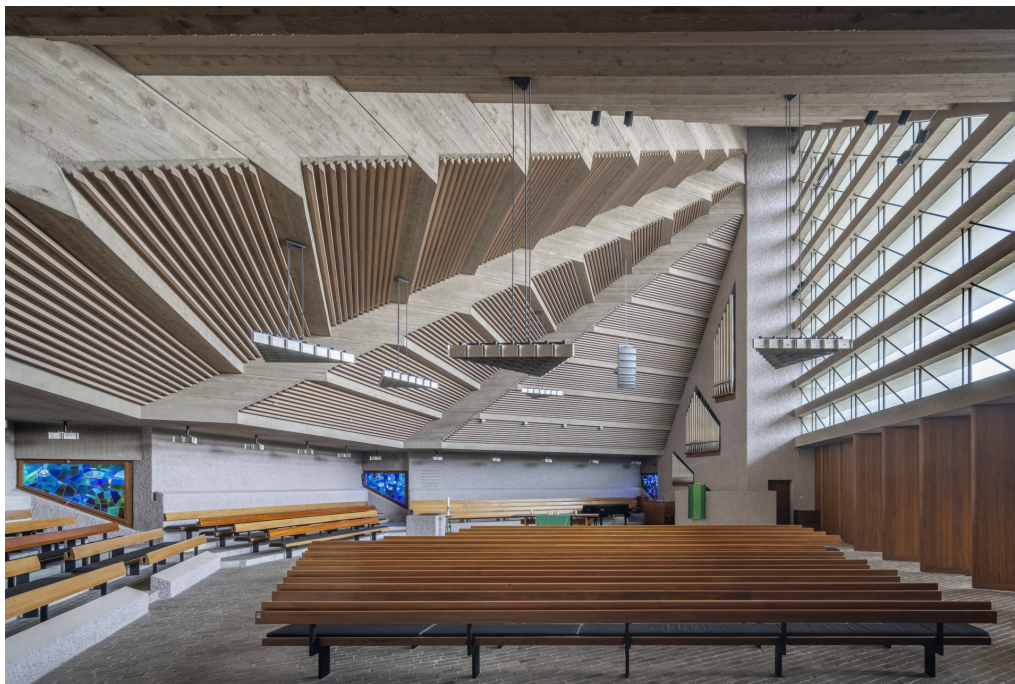
Ref. Kirche im Wil, ref. Kirche (Vers.-Nr. 03156), Kircheninnenraum, hinten rechts Glockenturm mit Orgelpfeifen, daran aufgehängt die Tragwerke des Dachs und der dreieckförmigen Fensterfassade, Blick nach NO, 01.09.2022 (Bild Nr. D104304_29).
