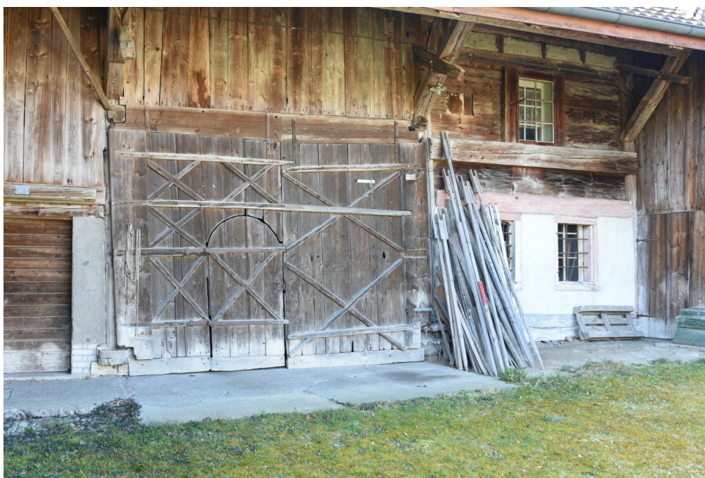
Vielzweckbauernhaus, Nordfassade, Ökonomieteil mit Tenntor und Schwellenschlössern der Aussenständer, rechts daneben Wohnteil mit urspr. Bohlenwand, 08.03.2022 (Bild Nr. D100593_21).
