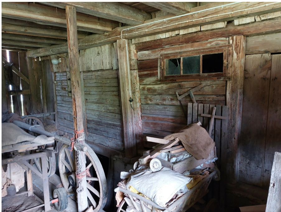
Vielzweckbauernhaus, urspr. Bohlenwand im Stall, Blick nach SO, 10.05.2022 (Bild Nr. D100691_94).
