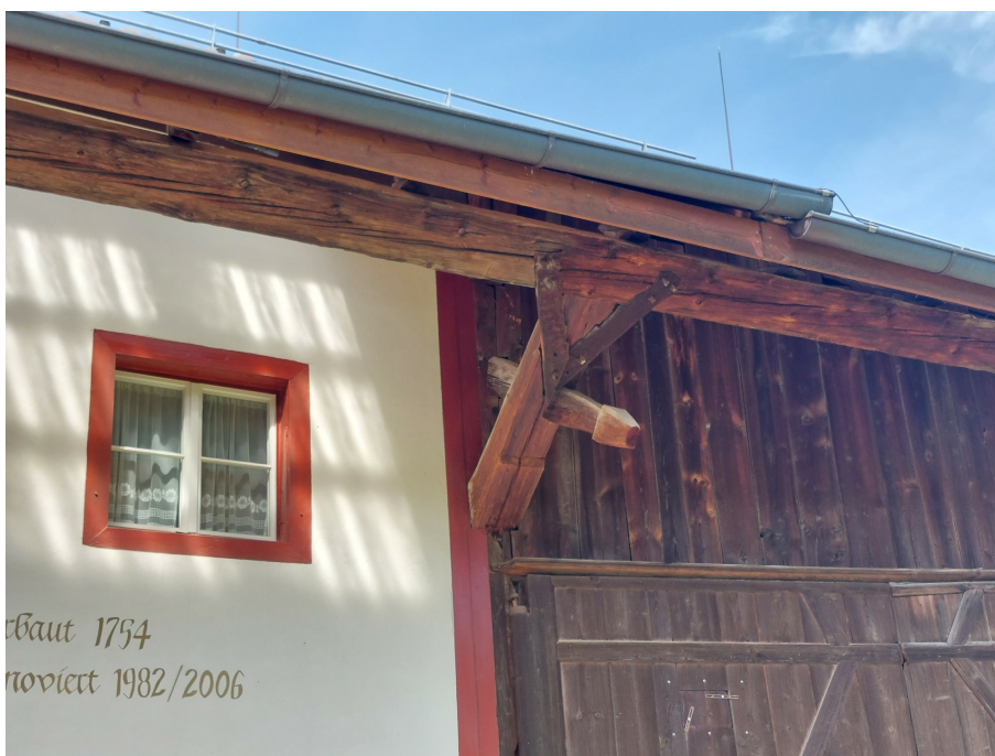
Vielzweckbauernhaus, Hauptfassade im S, Vordachabstützung mit Flugpfette, Bug, Zugband und überblattetem Kopfholz, 10.05.2022 (Bild Nr. D100691_93).
