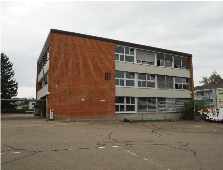
Primarschulanlage Wolfsmatt, Spezialraumtrakt (Vers. Nr. 02280), Ansicht von O, 06.10.2017 (Bild Nr. D100668_76).
