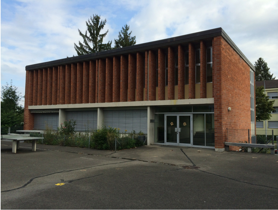
Primarschulanlage Wolfsmatt, Singsaaltrakt (Vers. Nr. 02284), Ansicht von S, 05.08.2014 (Bild Nr. D100658_67).
