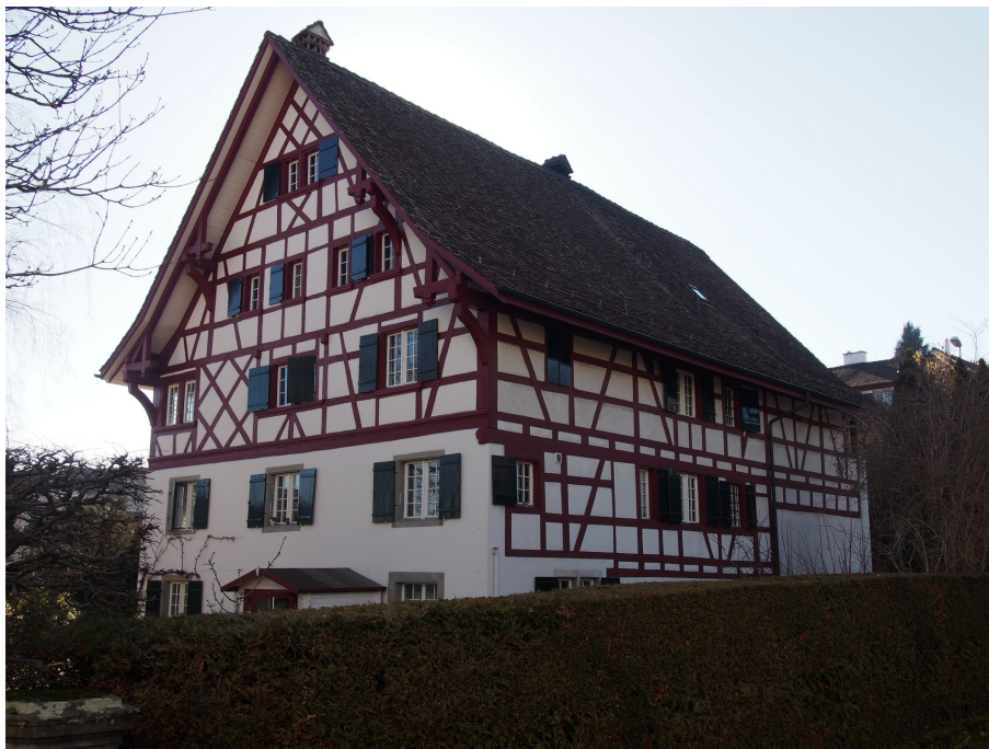
Ref. Pfarrhaus mit ehem. Zehntenscheune, Ansicht von NO, 25.02.2019 (Bild Nr. D101357_22).
