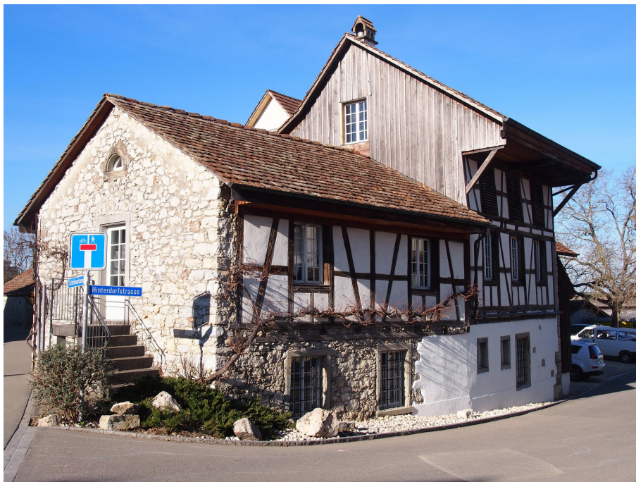
Ehem. Lohstampfe und Blaufärberei, Ansicht von S, 25.02.2019 (Bild Nr. D101357_14).
