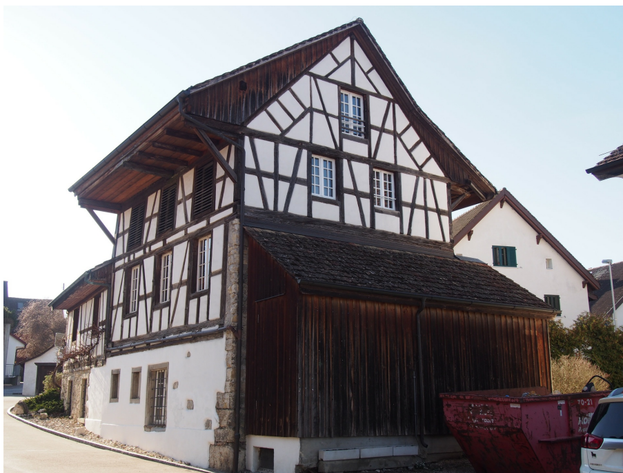
Ehem. Lohstampfe und Blaufärberei, Ansicht von NO, 25.02.2019 (Bild Nr. D101357_15).
