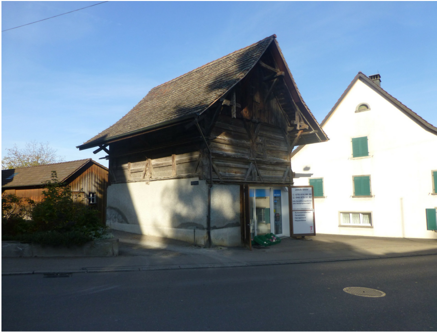
Speicher, Ansicht von SW, 25.02.2019 (Bild Nr. D101357_04).
