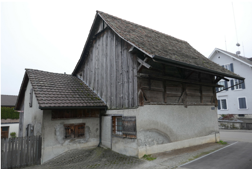
Speicher, Ansicht von NW, 05.12.2019 (Bild Nr. D101365_01).
