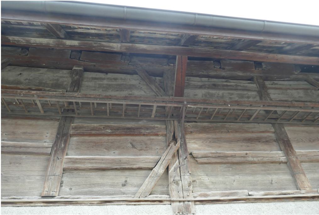
Speicher, Detail der westlichen Traufseite, Ansicht von W, 05.12.2019 (Bild Nr. D101365_04).
