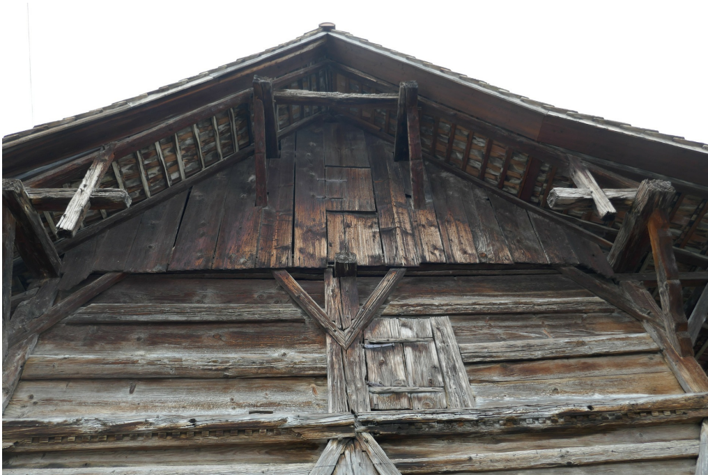
Speicher, südseitige Giebelfassade mit verziertem Brustriegel, Ansicht von S, 05.12.2019 (Bild Nr. D101365_02).
