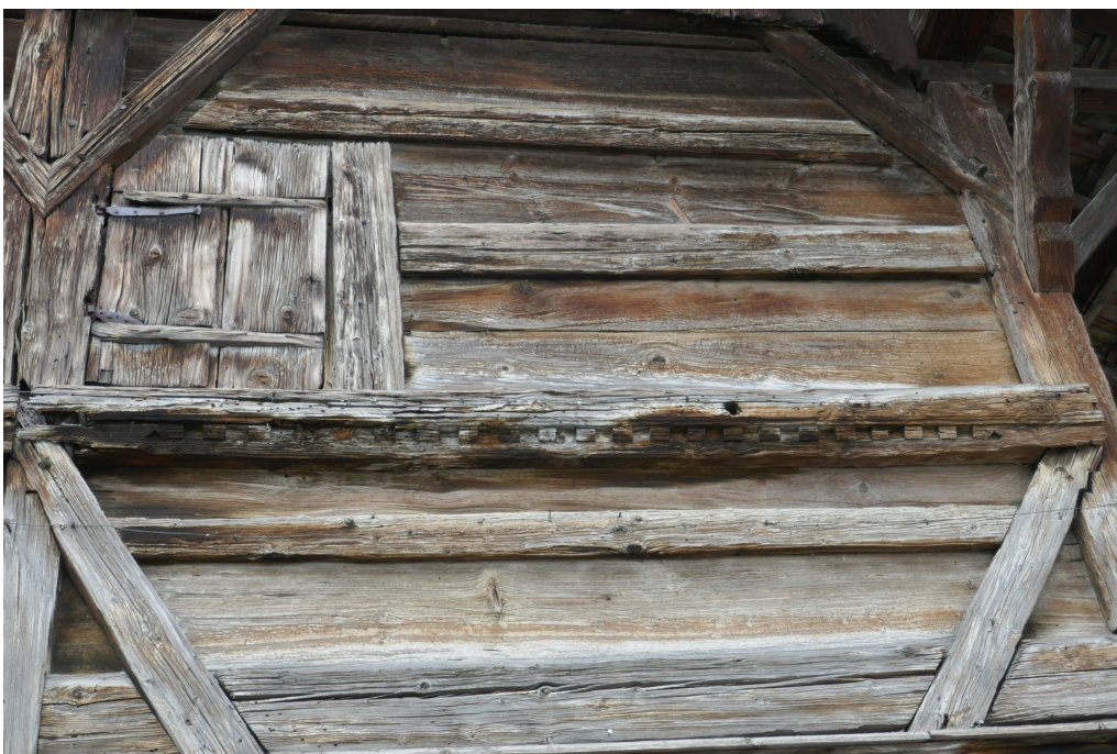
Speicher, Detail der südseitigen Giebelfassade, Ansicht von S, 05.12.2019 (Bild Nr. D101365_03).
