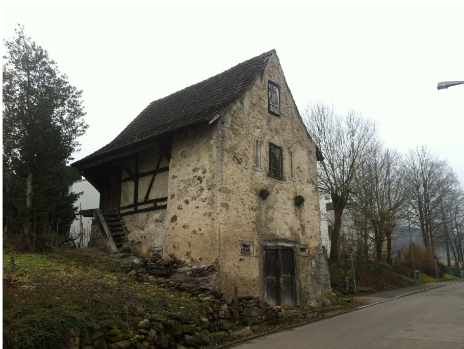
Trottspeicher im Hörnli, Ansicht von NO, 26.09.2013 (Bild Nr. D100654_63).
