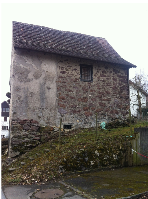
Trottspeicher im Hörnli, Ansicht von W, 26.09.2013 (Bild Nr. D100654_60).
