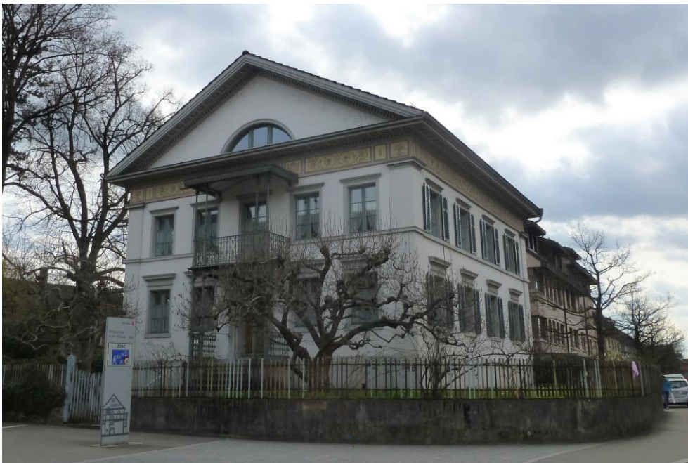
Wohnhaus «Zum Neuhof», Ansicht von N, 21.03.2017 (Bild Nr. D101097_61).
