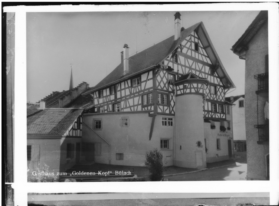
Gasthof «Zum Goldenen Kopf», Zustand vor dem Brand am 21./22.06.1962, Ansicht von NO (Bild Nr. D101805_52).
