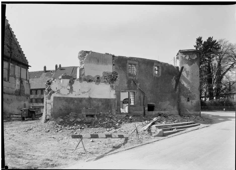
Gasthof «Goldener Kopf», Zustand nach dem Brand 1962, Ansicht von NO, 05.04.1965 (Bild Nr. U25854).
