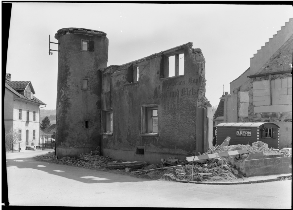
Gasthof «Goldener Kopf», Zustand nach dem Brand 1962, Ansicht von NW, 05.04.1965 (Bild Nr. U25853).
