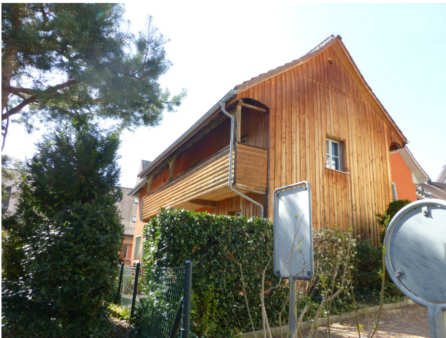
Wohnhaus, ehem. Bauernhaus, Ansicht von SO, 09.04.2015 (Bild Nr. D101117_52).
