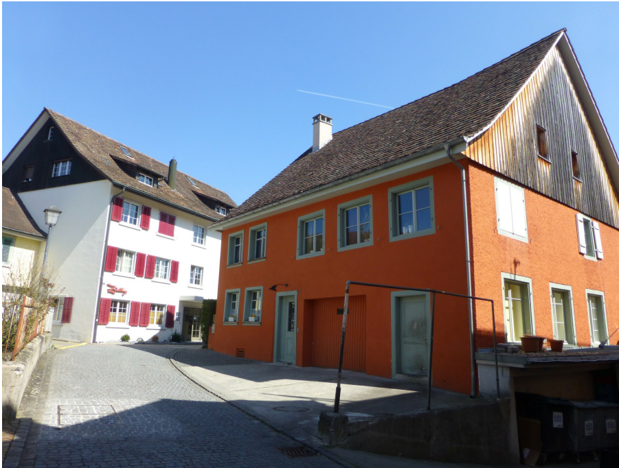
Wohnhaus, ehem. Bauernhaus, Ansicht von W, 09.04.2015 (Bild Nr. D101117_51).
