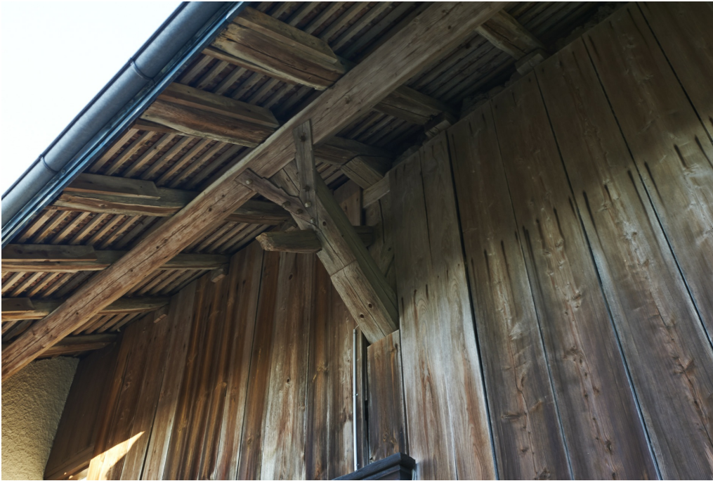
Ehem. Zehntenscheune, Ostfassade, Ausschnitt der Dachkonstruktion mit Vordachpfette und Stütze, 22.09.2017 (Bild Nr. D101764_02).
