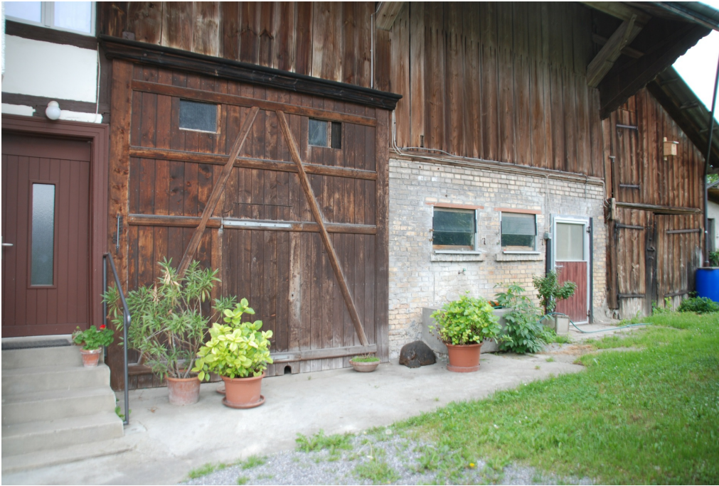
Ehem. Zehntenscheune, Ökonomieteil, Ostfassade, 09.06.2017 (Bild Nr. D101049_25).
