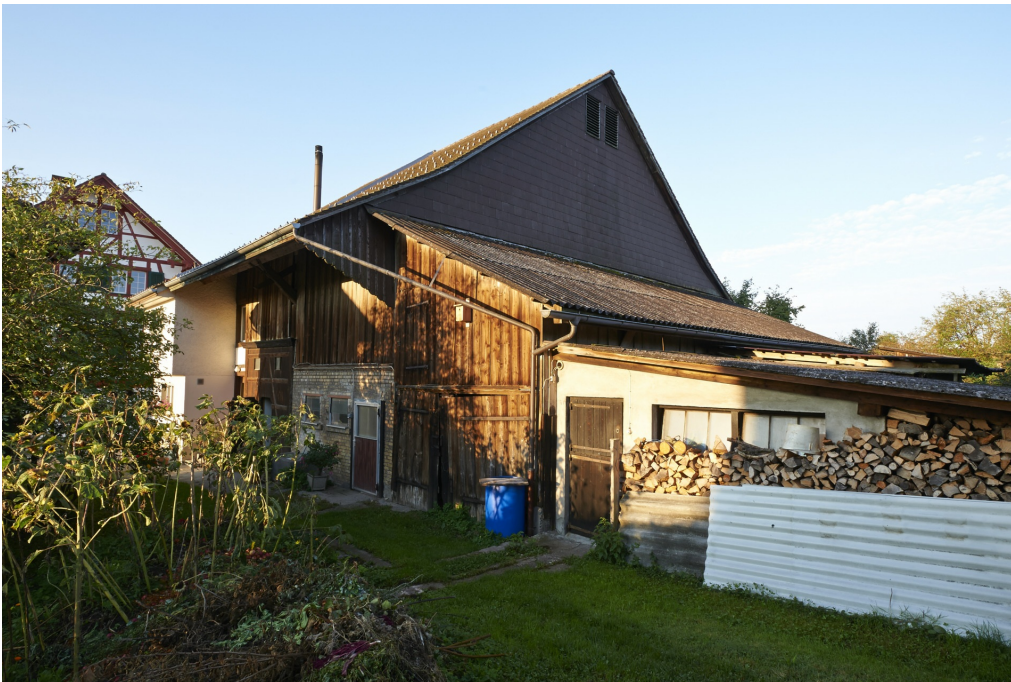
Ehem. Zehntenscheune, Ökonomieteil, Stall- und Schopfanbauten im N, Ansicht von NO, 22.09.2017 (Bild Nr. D101764_06).
