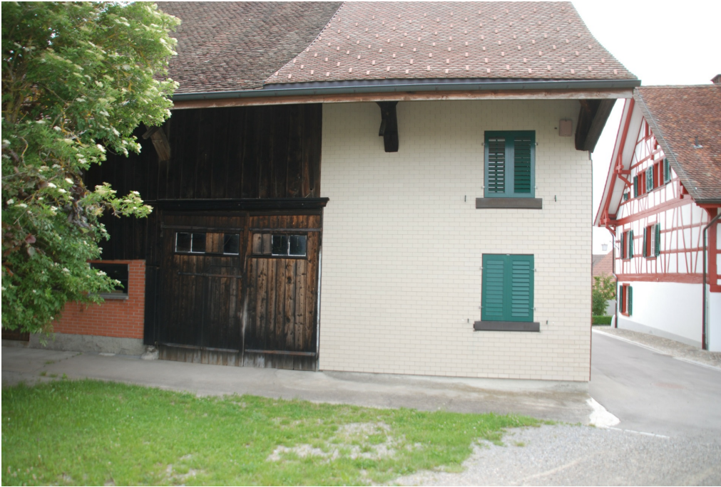
Ehem. Zehntenscheune, Wohnteil, Ansicht von W, 09.06.2017 (Bild Nr. D101049_18).
