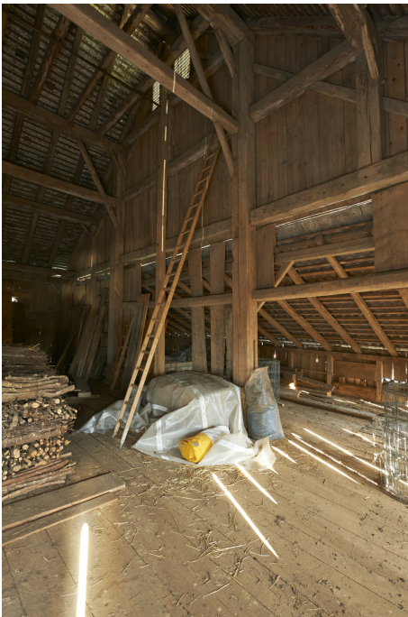
Ehem. Zehntenscheune, Ökonomieteil, nördlicher Abschluss des urspr. Dachstuhls, Ansicht von SW, rechts das abgeschleppte Dach des ersten nördlichen Anbaus, 22.09.2017 (Bild Nr. D101764_47).
