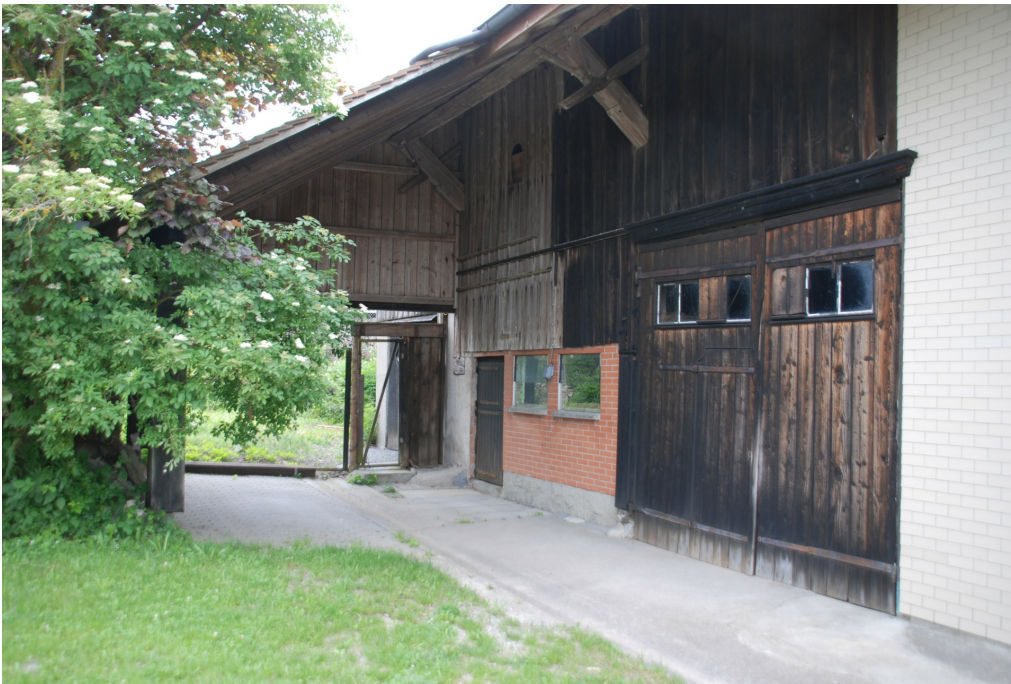
Ehem. Zehntenscheune, Westfassade, Ansicht von SW, 09.06.2017 (Bild Nr. D101049_17).
