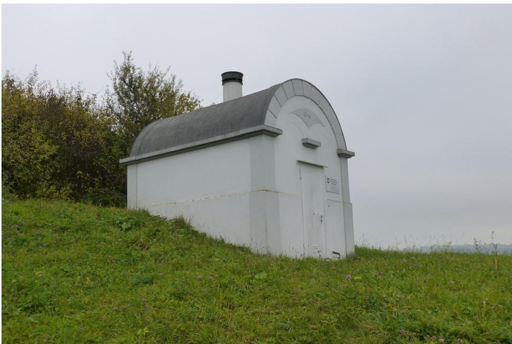
Reservoir Schürmatt, Ansicht von O, 31.10.2016 (Bild Nr. D101078_02).
