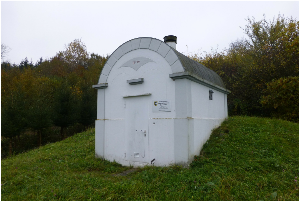
Reservoir Schürmatt, Ansicht von N, 31.10.2016 (Bild Nr. D101078_01).
