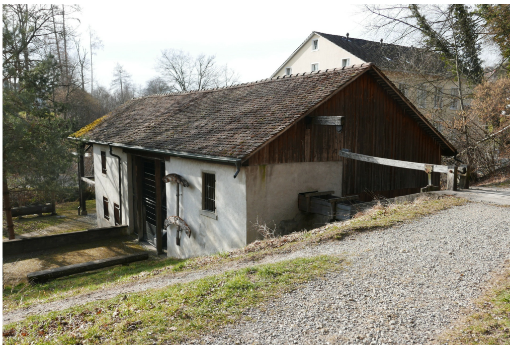
Sagi, Sägereigebäude (Vers. Nr. 00636), links Radhaus mit neu erstelltem Holzkanal für den Wasserradzulauf (052WR-I0175-03), Ansicht von O, 13.02.2022 (Bild Nr. D100590_60).
