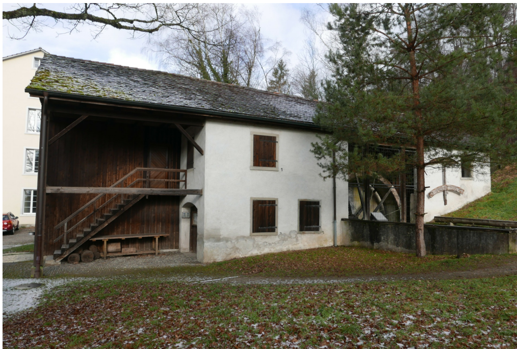
Sagi, Sägergebäude (Vers.-Nr. 00636), Südostfassade, neu geschaffener Eingangsbereich sowie vergrößerte Maueröffnung im Radhaus, 27.01.2022 (Bild Nr. D100590_54).
