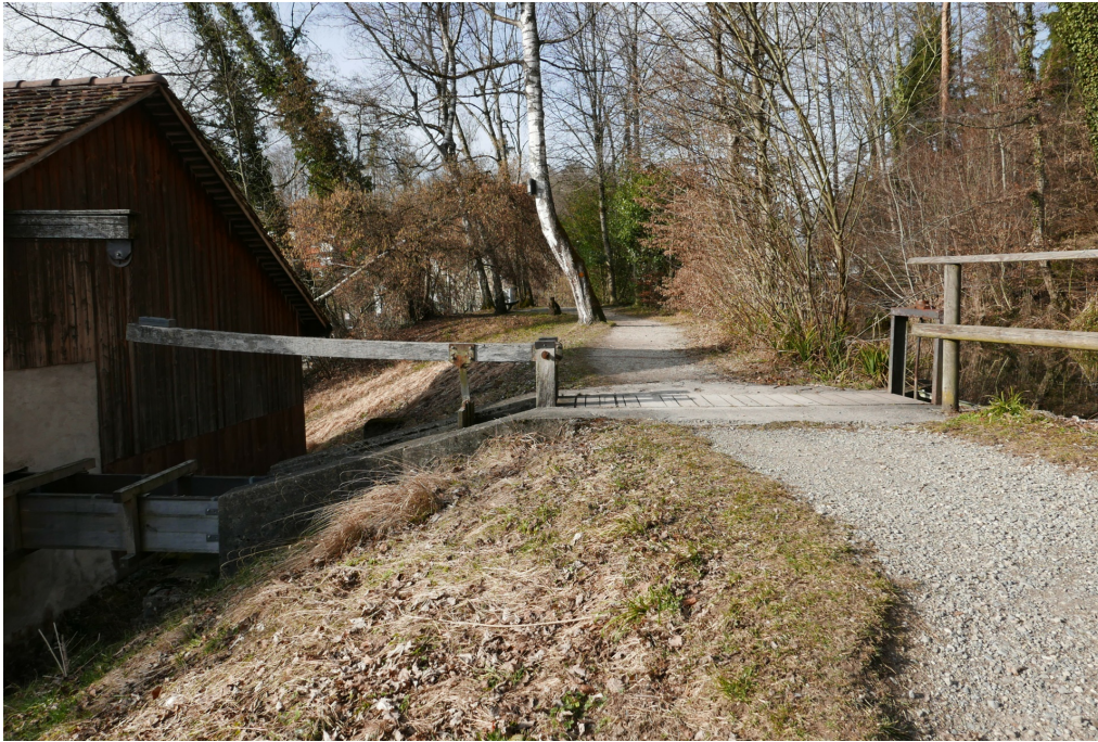
Sagi, Sägereigebäude (Vers. Nr. 00636), rechts Weiher (052WR-I0175-02) mit Hauptschieber zur Regulierung des Wassers, links Holzkanal mit Hilfsschieber für den Wasserradzulauf (052WR-I0175-03), Ansicht von SO, 13.02.2022 (Bild Nr. D100590_62).
