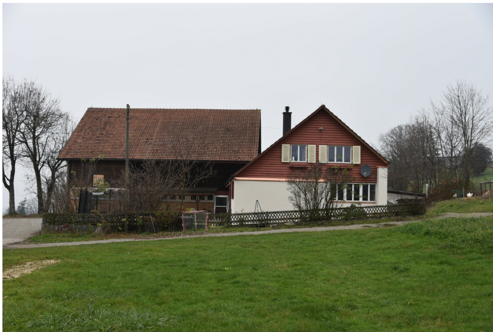
Landwirtschaftliche Siedlung Maag, nach Fassadenisolation des Wohnhauses 2020, Ansicht von SO, 25.11.2020 (Bild Nr. D100569_51).
