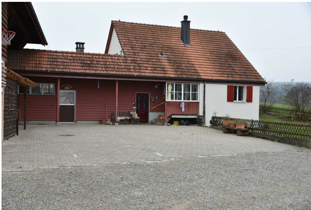
Landwirtschaftliche Siedlung Maag, nach Fassadenisolation des Wohnhauses 2020, Ansicht von SW, 25.11.2020 (Bild Nr. D100569_58).
