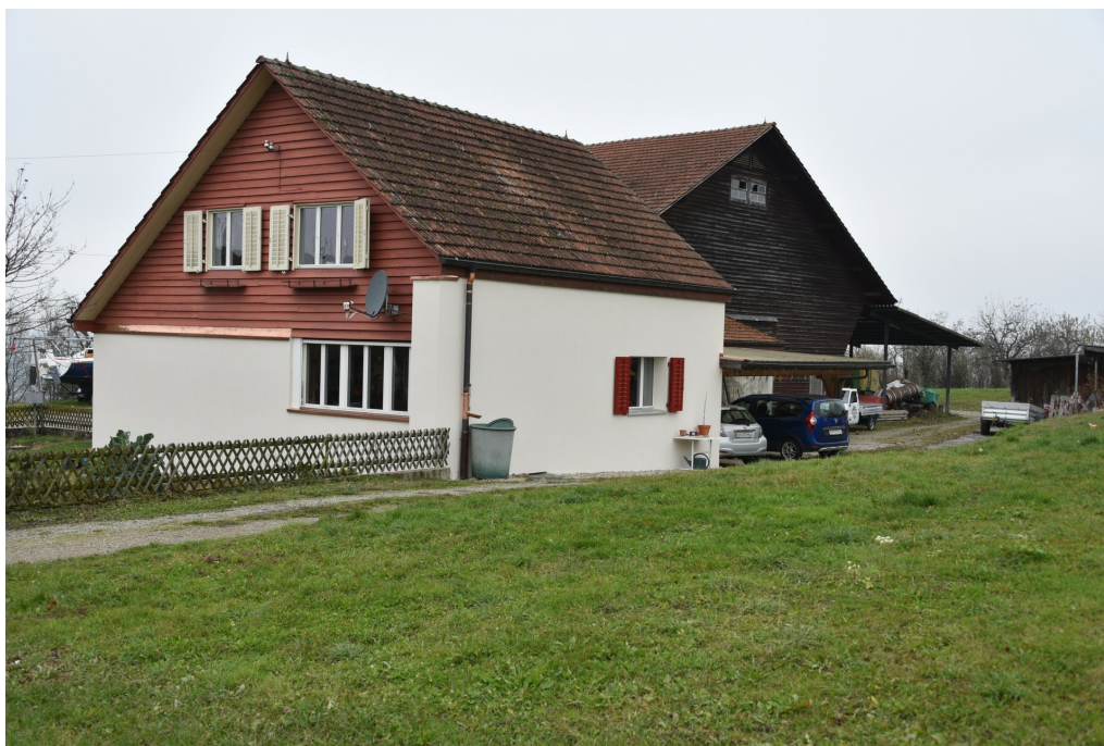
Landwirtschaftliche Siedlung Maag, nach Fassadenisolation des Wohnhauses 2020, Ansicht von O, 25.11.2020 (Bild Nr. D100569_62).
