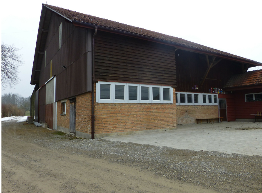
Landwirtschaftliche Siedlung Maag, Ökonomieteil, Ansicht von S, 17.02.2015 (Bild Nr. D100569_34).
