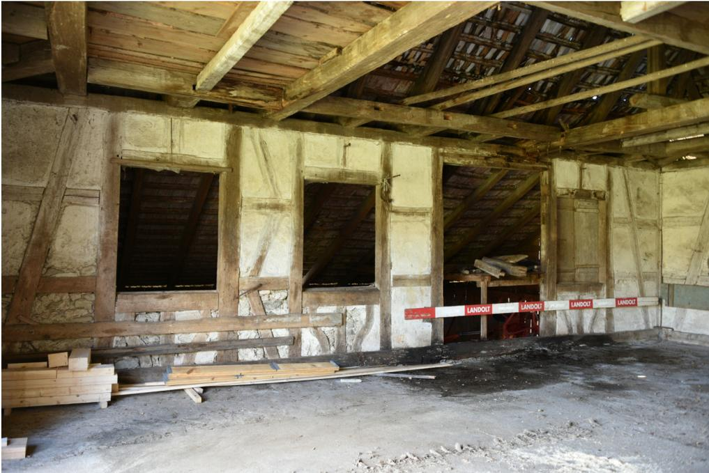
Ehem. Schützenhaus, Hauptbau von 1792, Nordostwand, Fachwerkkonstruktion mit Fensteröffnungen, hinten Schleppdach des Schopfs von 1922, 15.03.2023 (Bild Nr. D100685\_38).
