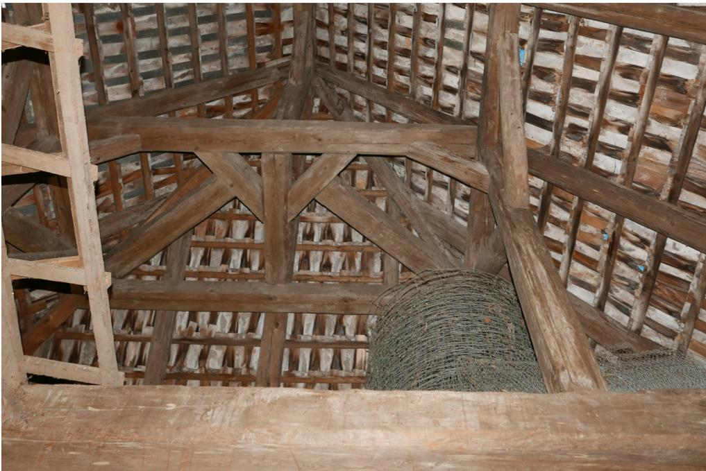
Ehem. Schützenhaus, Hauptbau von 1792, Dachkonstruktion mit stehendem Dachstuhl, Stuhlrähm, Firstsäule und Sparren, 15.03.2023 (Bild Nr. D100697\_39).
