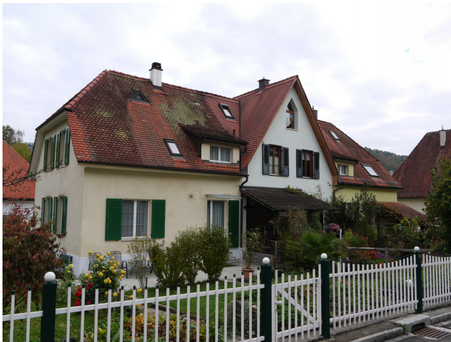
Siedlung Sihlau, Dreifachwohnhaus Typ B-C-B (Vers. Nr. 01034, 01035, 01036), Ansicht von NW, 19.11.2021, (Bild Nr. D100691_19).
