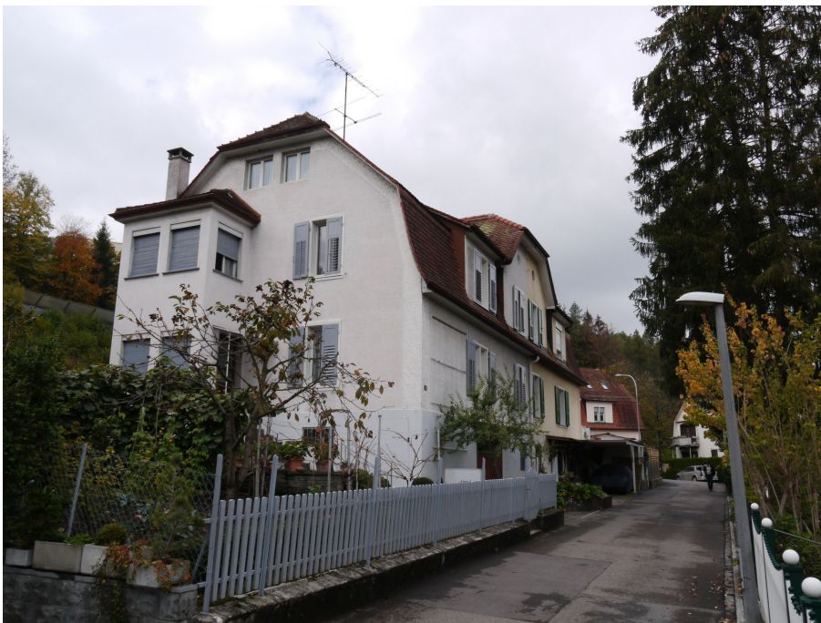
Siedlung Sihlau, Doppelwohnhaus Typ II, (Vers. Nr. 01050, 01049), Ansicht von SO, 23.10.2015 (Bild Nr. D100691_17).
