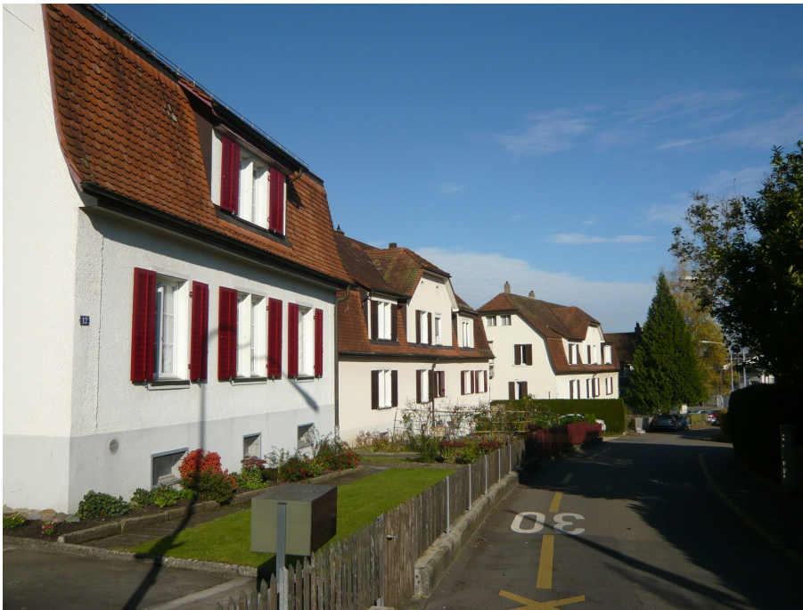
Siedlung Sihlau, vorne links Einzelwohnhaus Typ I (Vers. Nr. 00110), in der Mitte Doppelwohnhaus Typ II (Vers. Nr. 01055, 01056), rechts Doppelwohnhaus Typ II (Vers. Nr. 01054, 01053), Ansicht von SO, 31.10.2014 (Bild Nr. D101301_11).
