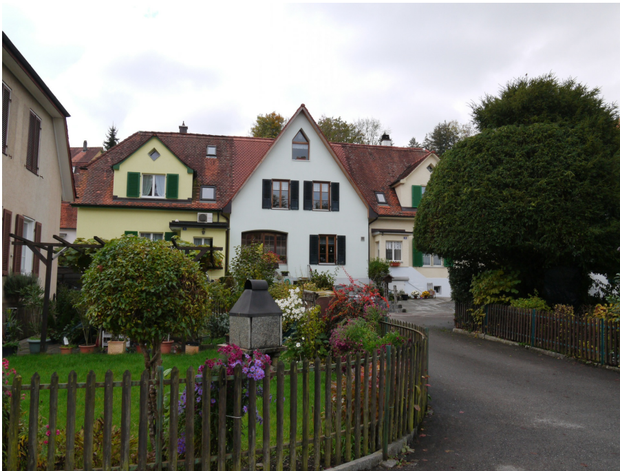
Siedlung Sihlau, Dreifachwohnhaus Typ B-C-B (Vers. Nr. 01034, 01035, 01036), Ansicht von NO, 19.10.2015 (Bild Nr. D100691_12).
