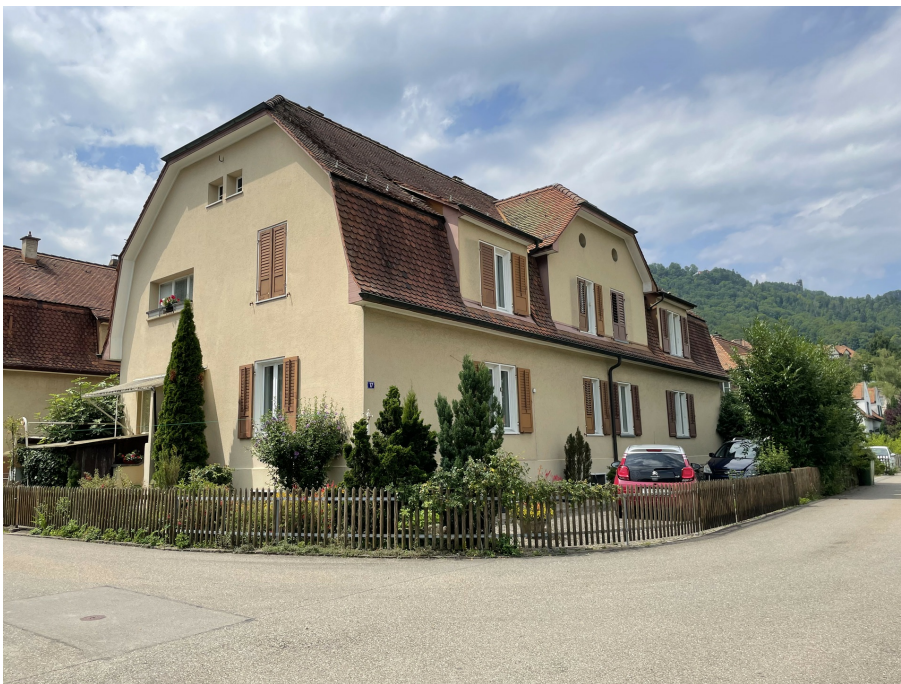
Siedlung Sihlau, Doppelwohnhaus Typ F (Vers. Nr. 01040, 01039), Ansicht von O, 27.07.2021 (Bild Nr. D100691_14).
