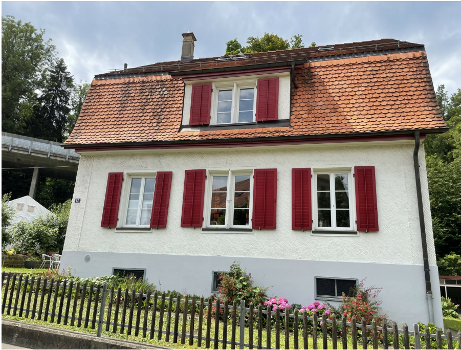
Siedlung Sihlau, Einzelwohnhaus Typ I (Vers. Nr. 00110), Ansicht von O, 27.07.2021 (Bild Nr. D100691_15).
