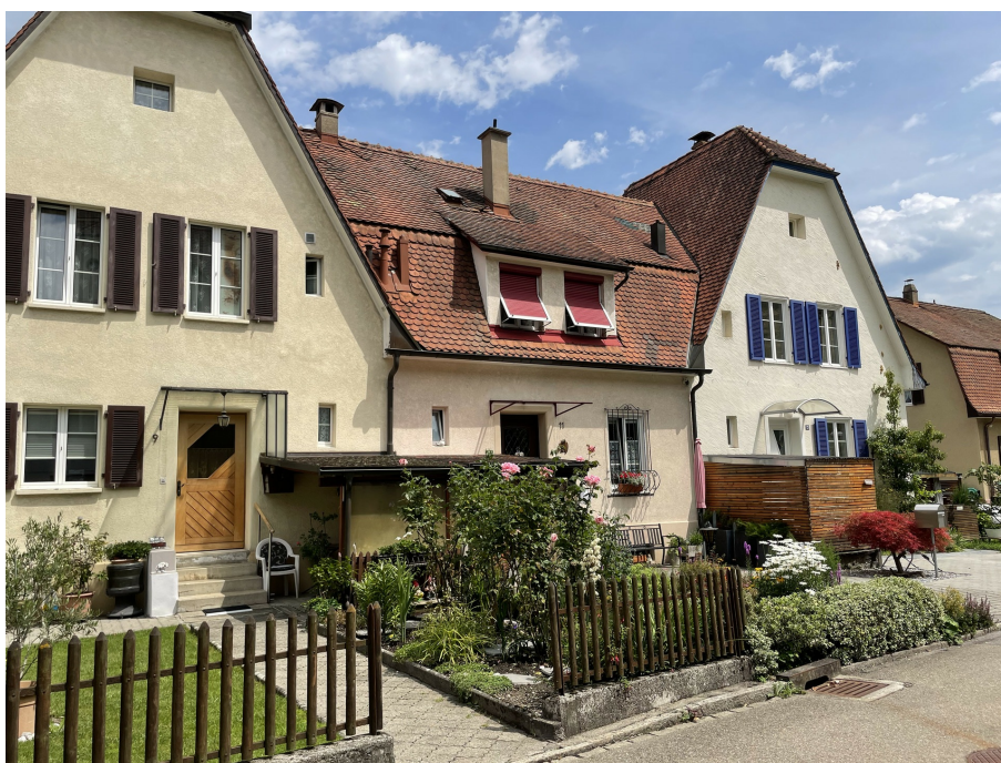
Siedlung Sihlau, Dreifachwohnhaus Typ D-E-D (Vers. Nr. 01046, 01047, 01048), Ansicht von NW, 27.07.2021 (Bild Nr. D100691_13).
